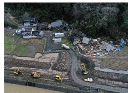
現場上空写真
