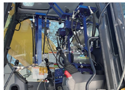
遠隔操作装置の設置状況
