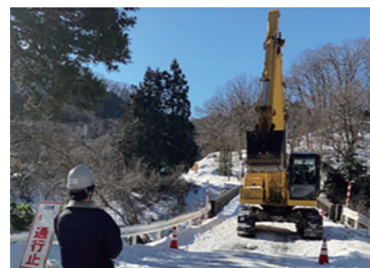
遠隔操作施工機械の走行状況
