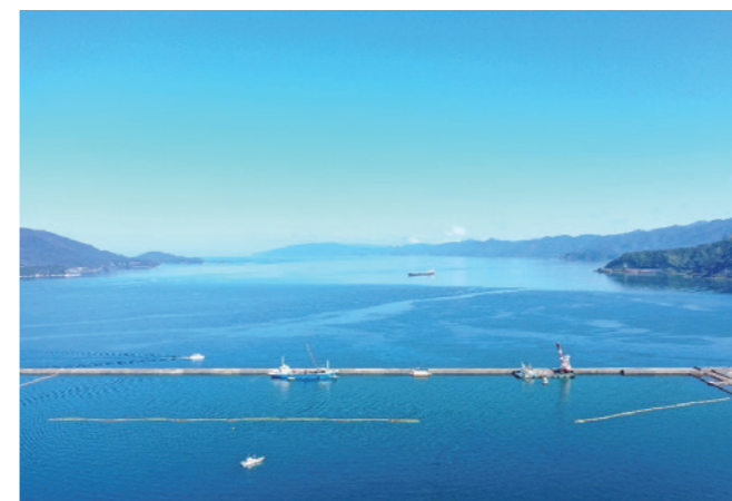
施工区域全域(別件工事含む)
