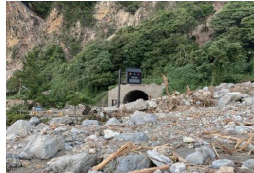
坑口部 倒木・斜面崩落
