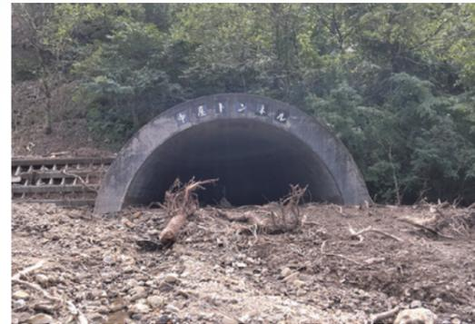
坑口で土石流発生 土砂堆積
