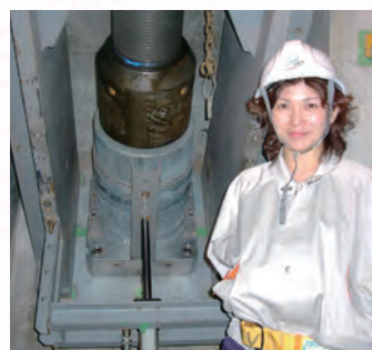
◀斜張橋の現場にて
