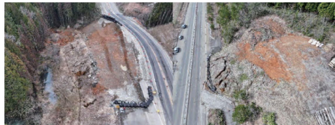
「DJI Dock 3」で撮影した現場の様子
