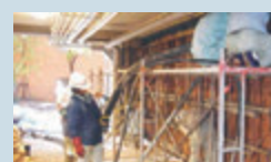
在来工法の施工風景
