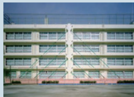
耐震補強 施工状況
