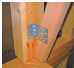
筋交いと柱・土台の緊結
