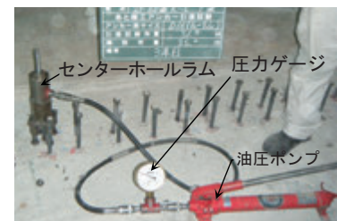
図 3-12-9 非破壊試験（引張試験）実施例
