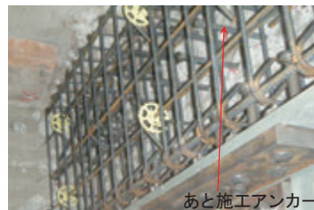
図 3-13-1 梁増打ち施工例
