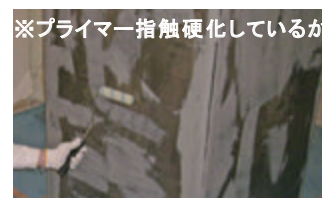
図 3-16-4 接着樹脂下塗り
