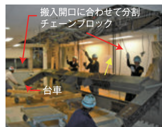
図 3-14-3 鉄骨ブレース建方状況
