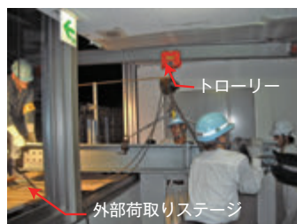
図 3-14-2 鉄骨搬入状況
