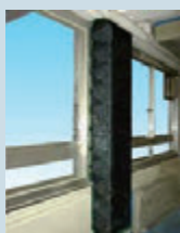
柱補強の例
