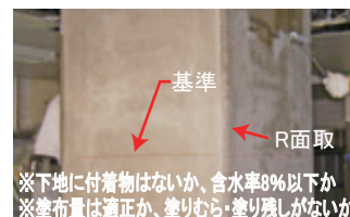
図 3-16-2 プライマー塗布
