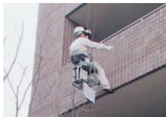
写真2 簡易ゴンドラによる打診調査
