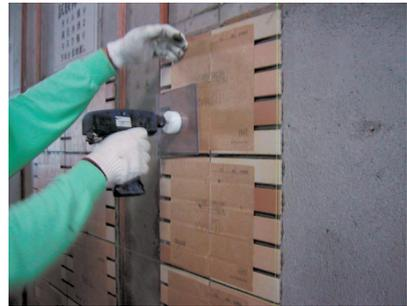
写真2 ユニットタイルへの振動工具の応用
