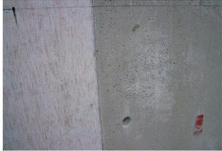
写真2 普通合板型枠による躯体
