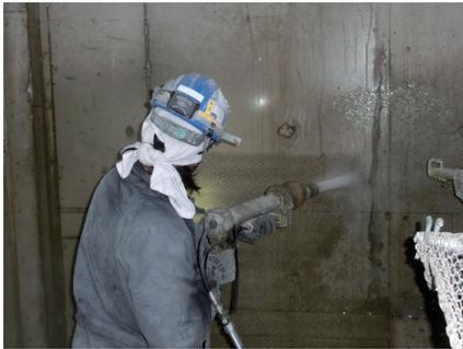
写真2 超高圧水洗処理状況
