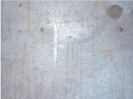
写真3 表面加工コンクリート型枠用合板型枠による躯体
