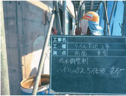
写真1 吸水調整材塗布状況
