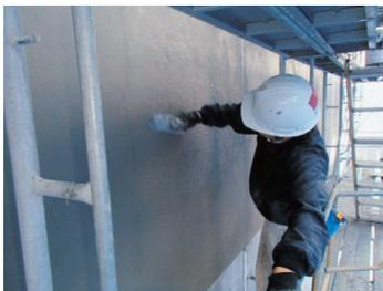
写真5 タイル下地塗り付け状況
