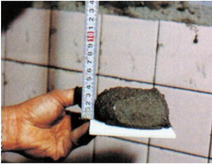
写真1 積上げ張り<sup>2)</sup>
