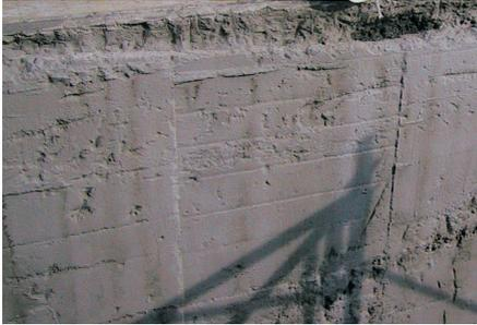
写真1 バラ板型枠による躯体
