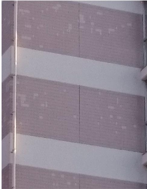
写真1 タイル部分張替えにより改修部分が目立つ例
