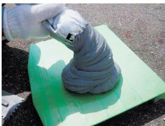
写真1 包装より出した時点から硬化が始まる<sup>1)</sup>
