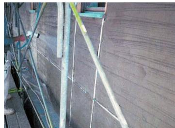
写真6 タイル下地散水養生状況
