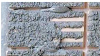
写真4 充填不良の例
