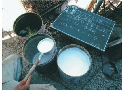
写真2 吸水調整材計量管理状況
