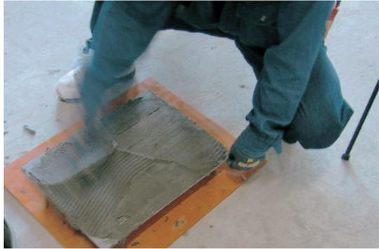
写真1 マスク張りの施工状況
