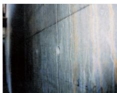
上階打設後のコンクリート水による汚れ<sup>1)</sup>
