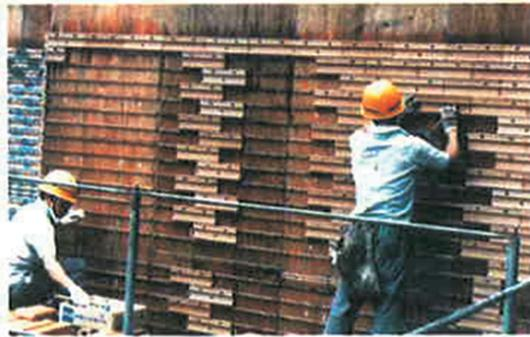
写真1 型枠先付け工法<sup>1)</sup>
