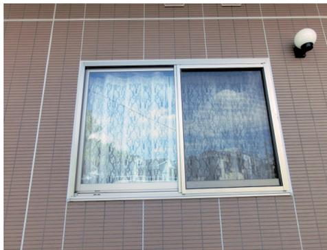
写真1 パネル割に合わせたタイル割（写真はALCの場合）
