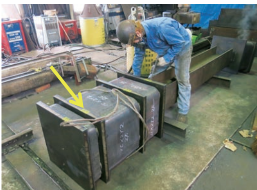
柱 / 梁パネルゾーン：通称タイコの仮組み
