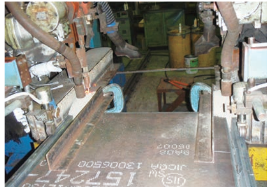
サブマージアーク溶接（四面BOX）
