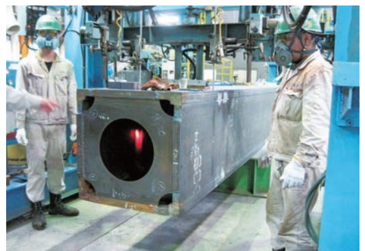
エレクトロスラグ溶接状況
