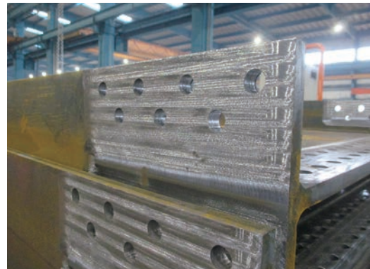
ボルト接合部の処理
