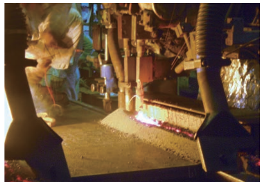
サブマージアーク溶接（四面BOX）
