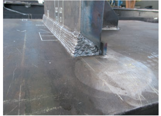
溶接部の外観確認
