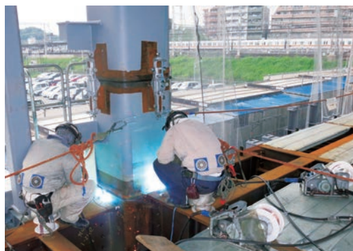
半自動アーク溶接
