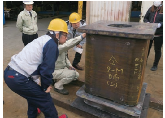
本溶接前の組立検査
