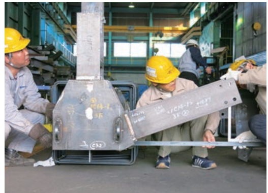
仕口角度の検査状況
