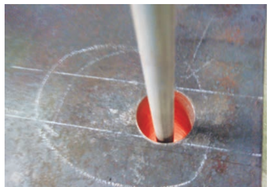
エレクトロスラグ溶接状況（溶接用穴より）
