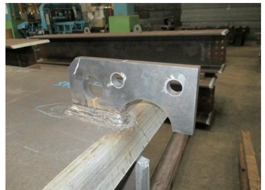
仮設ピースの取り付け状況確認 (写真は梁の下がり止め兼吊りピース)
