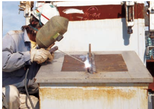
被覆アーク溶接
