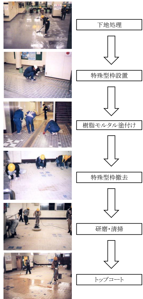
施工プロセス 2)
