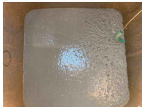
コンクリート天端（打継ぎ位置）の状況
