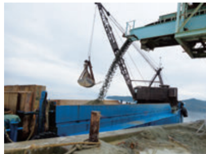
（ガット船への積み込み作業状況）
