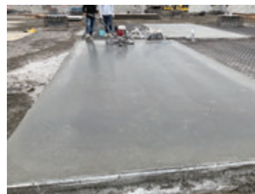
物流倉庫床の施工試験
