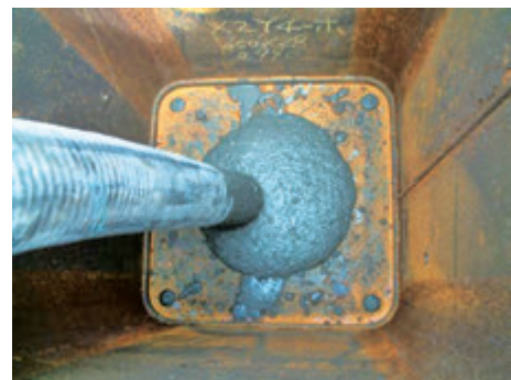
ブーム車による落とし込み充填工法
