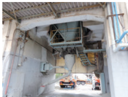
⑧ 積み込みホッパ（洗浄中）
