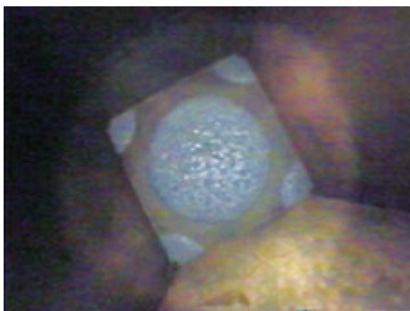
鋼管柱内部の圧入状況
