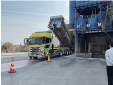
骨材の受入れ状況
