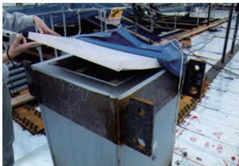
柱頭部の雨養生（例）
