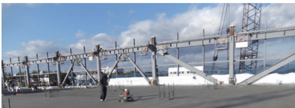
スラブの防風養生（標準期の朝夕の温度差が大きい条件においてもドライアウト防止の効果がある）
