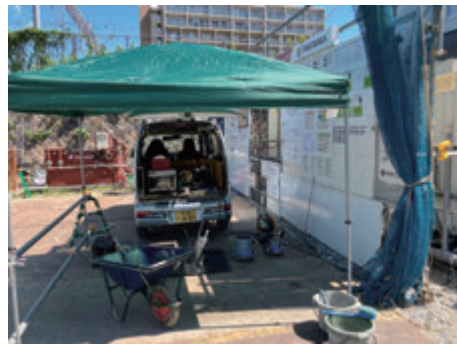
試験場所の仮設テント
