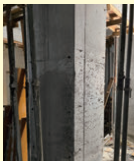
溜まり水にコンクリートの 打込み、締固めを行った状況
