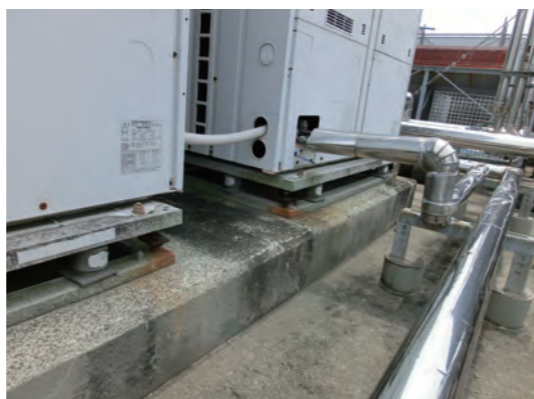
写真3 盛替えのできない配管や基礎
