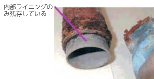
写真1 破断した配管
