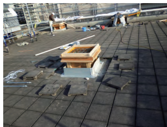
写真2 屋上設備基礎施工状況
