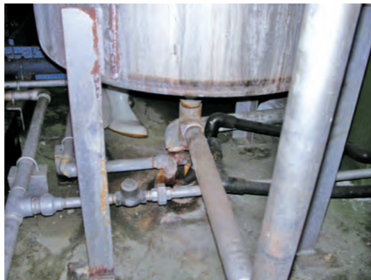
写真1 老朽化した配管・バルブ類
