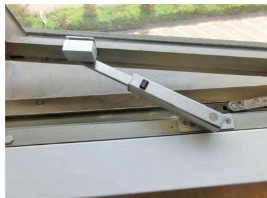
写真2 開放制限取付状況（竖すべり出し窓）
