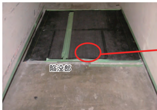
写真1 養生箇所全景 (下地 栈木@450、コンパネ t-9mm、の上ゴムマット敷)
