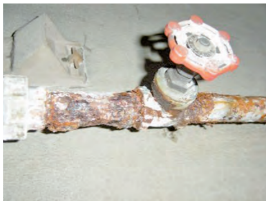
写真2 老朽化したバルブ
