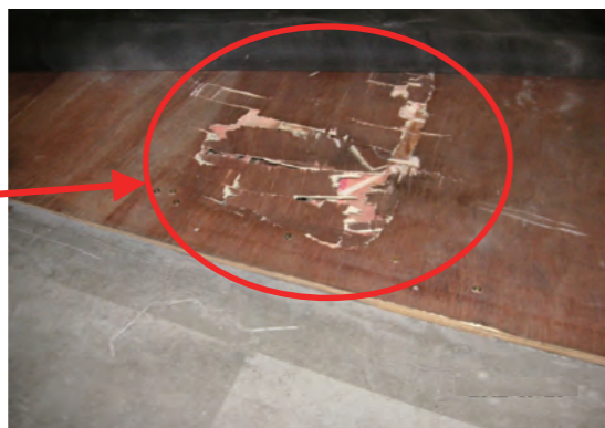
写真2 養生陥没部接写 (ゴムマットをめくった状況)
