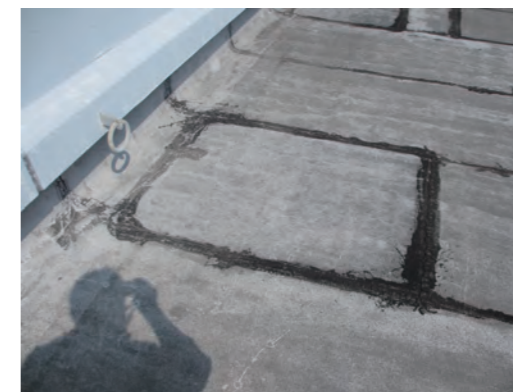
写真1 部分改修の事例
