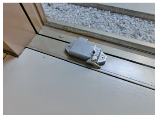
写真3 開放制限取付状況（引違い窓）
