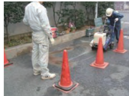
写真1 舗装のカッター切断作業状況
