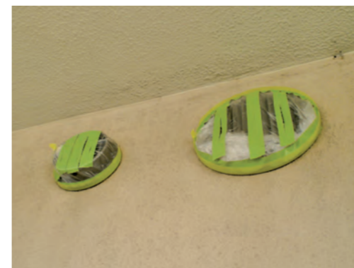
写真1 給気口養生状況
