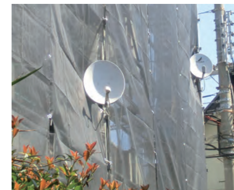
写真3 足場架設に伴い電波受信が難しくなるため、足場の外側に盛替えた例
