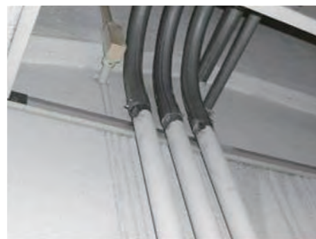
写真1 既存壁裏面側 (貫通穴よりグラウト材が漏れ出している)
