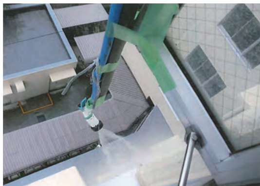
写真1 散水によるクラック調査状況
