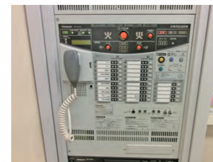
写真2 非常用警報設備
