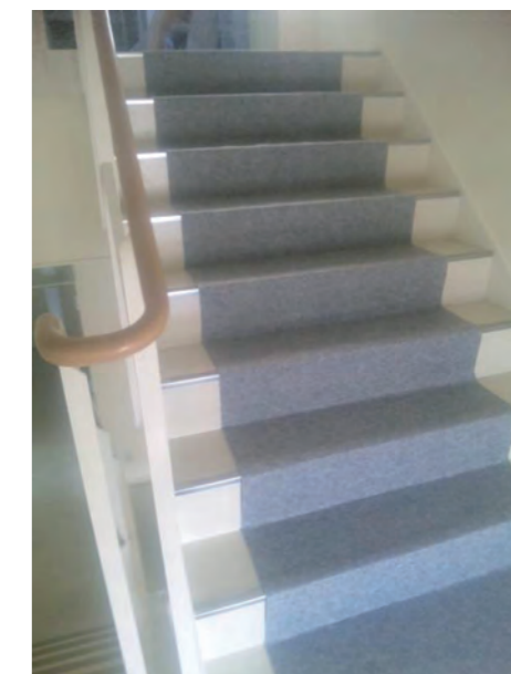
写真2 パンチカーペット 2)
