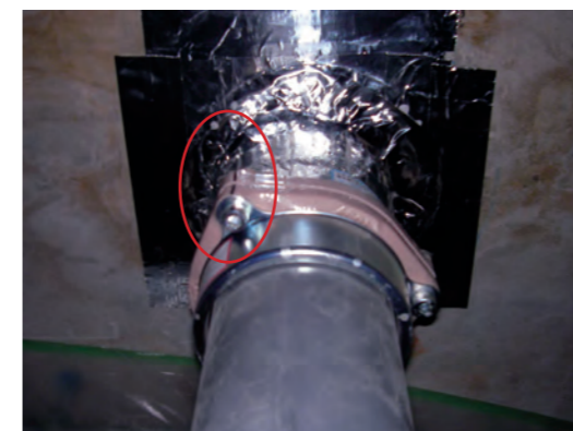
写真4 配管施工後のマーキング確認
