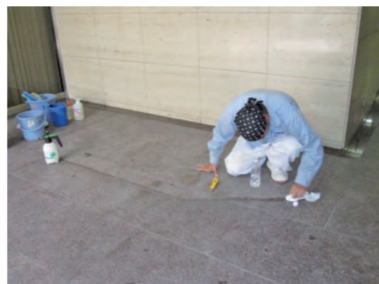
写真3 シミ抜き施工状況
