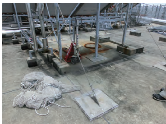
写真2 屋上にはべた基礎がたくさん
