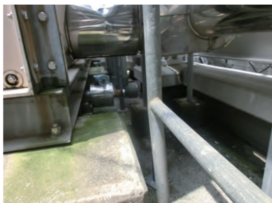
写真1 防水するにも体が入っていかない
