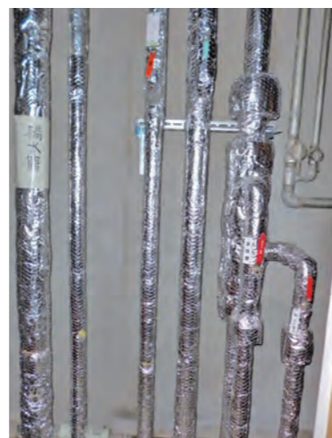
写真1 給水給湯配管
