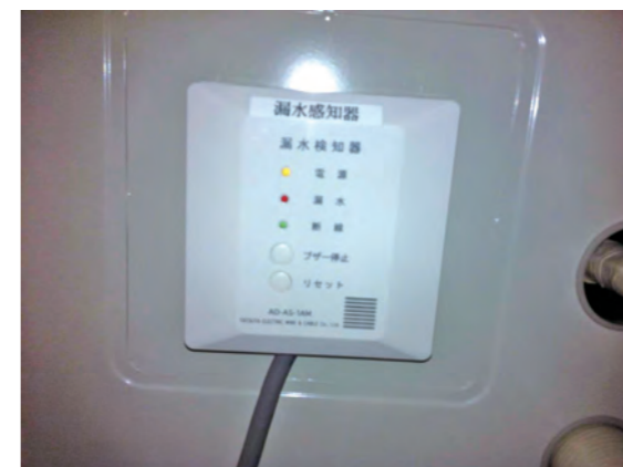
写真3 漏水検知器 (本体)
