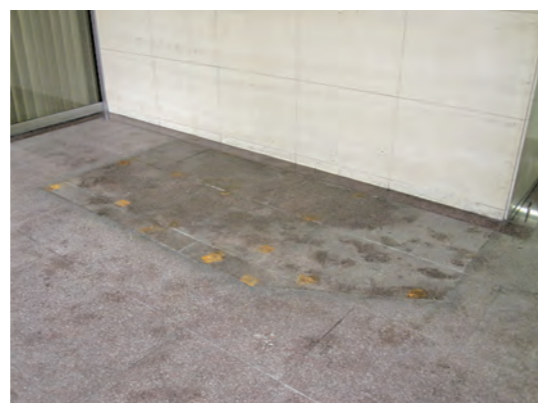
写真2 撤去後床状況
