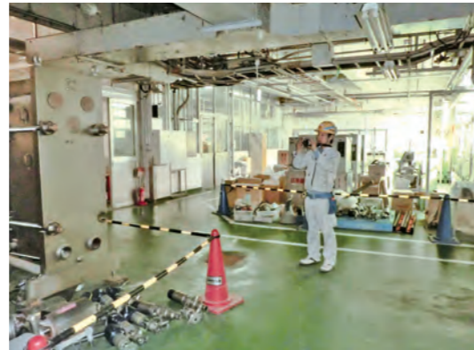
写真1 工事着手前の撮影状況
