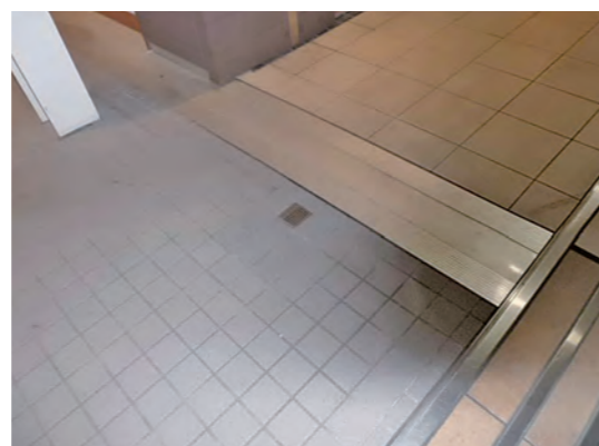
写真1 排水口取付処置後
