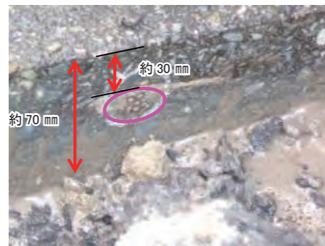
写真2 ループコイル線の破断状況
