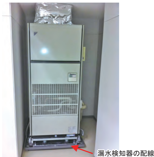
写真1 漏水検知器の配線 設置位置
