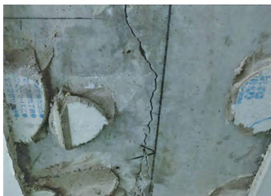
写真2 内装撤去後の内部クラック状況
