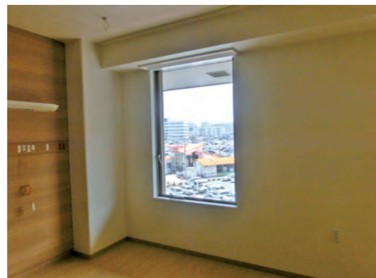
写真1 改修後、窓を全開した状況 （転落の恐れあり）
