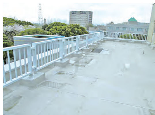
写真2 屋上の水溜り状況
