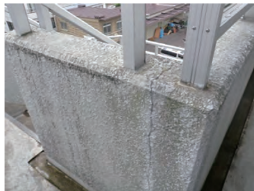
写真1 廊下手摺のクラック
