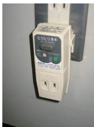
写真1 漏電遮断器 (過負荷対応機能なし)
