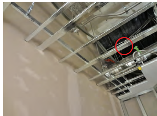
写真1 配線切断部
