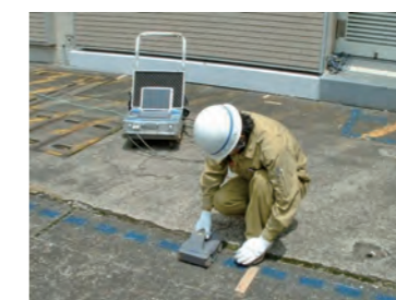
写真4 表層部対応型レーダーによる埋設物探査状況
