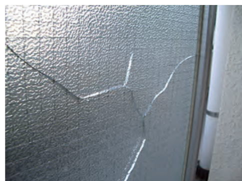
写真1 熱割れしたガラス
