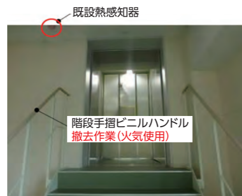
写真1 熱感知器誤作動状況
