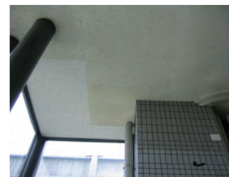
写真1 天井仕上の岩綿吸音板を部分補修した跡が目立つ例
