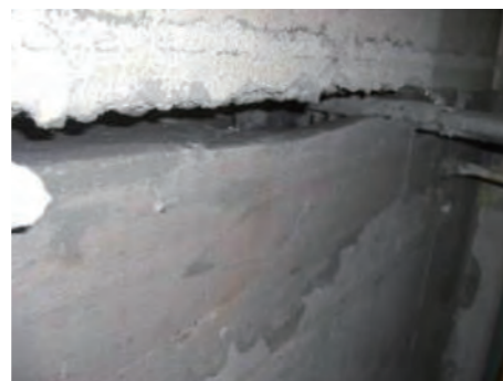
写真2 グラウト注入箇所 (漏れ出しのため空隙を生じている)
