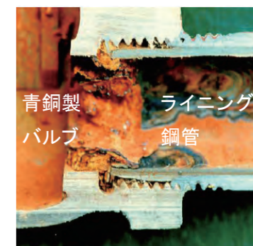
写真2 バルブと鋼管接続部の腐食 1)
