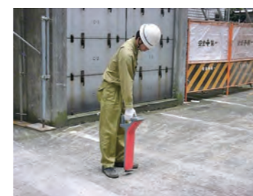
写真3 鉄管・ケーブル探知機による埋設物探査状況
