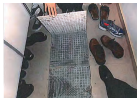
写真1 床タイルを剥がした状況
