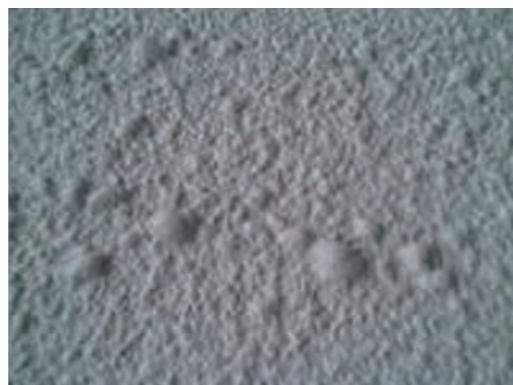
写真2 塗膜のふくれ
