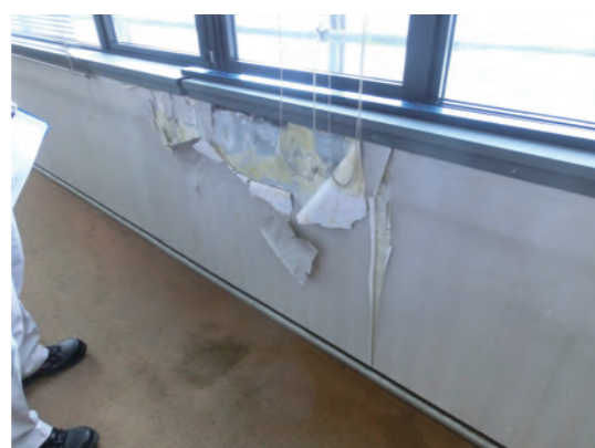
写真1 下地ボード状況
