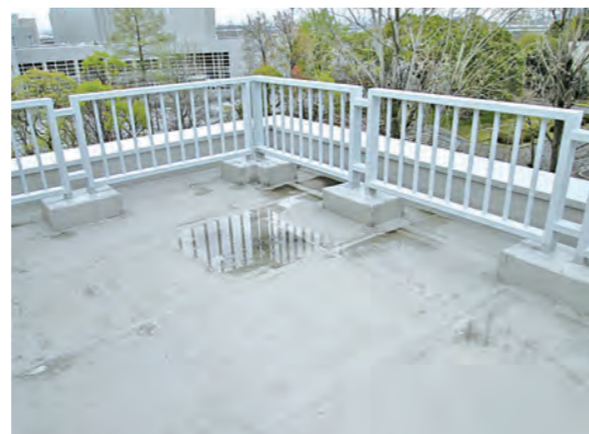
写真1 屋上の水溜り状況
