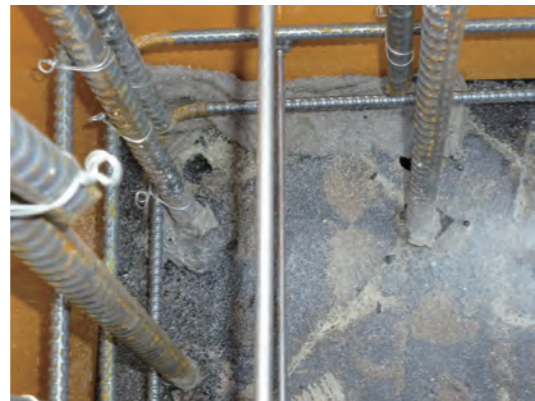
写真1 アンカー打設削孔状況
