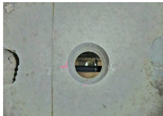
写真1 コア抜き状況
