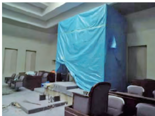
写真1 解体中の養生状況
