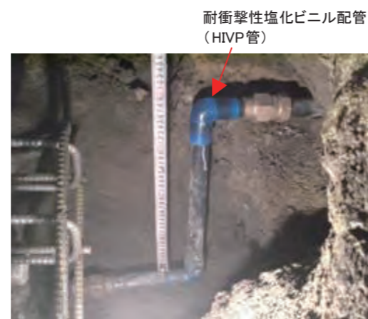
写真2 埋設給水配管
