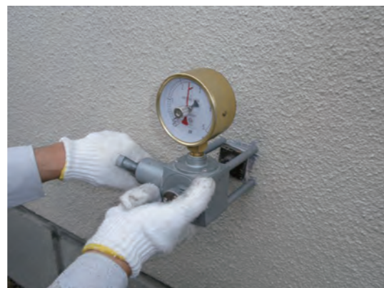
写真2 建研式接着力試験器にて、付着力を測定
