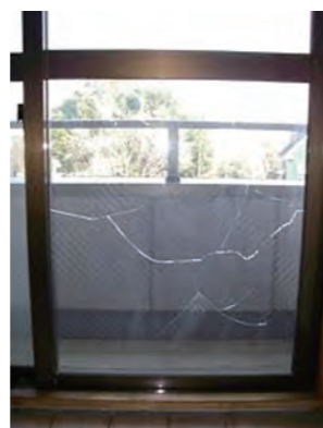
写真2 熱割れしたガラス
