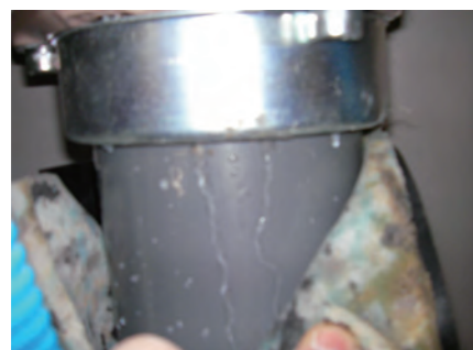
写真1 漏水状況
