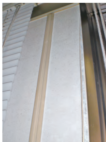
写真1 クロス剥がれ状況
