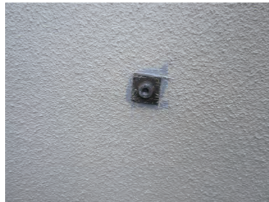
写真1 塗膜付着力試験：アタッチメント取付
