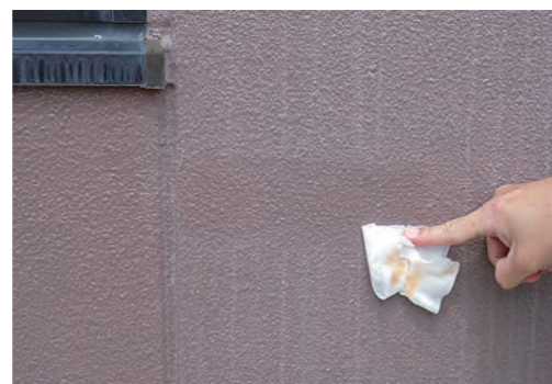
写真1 壁の汚損状況 (庇および窓の水切の下では汚損が見られない)
