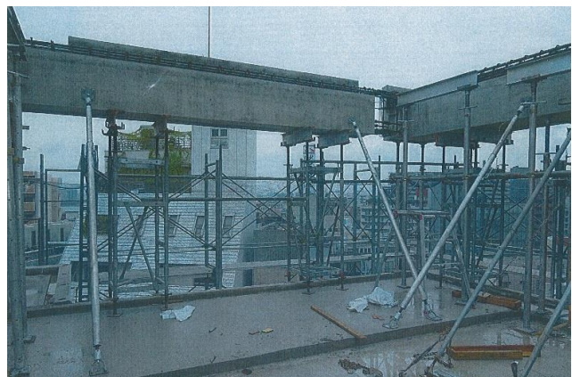
写真10 梁位置直し用サポート 1)
