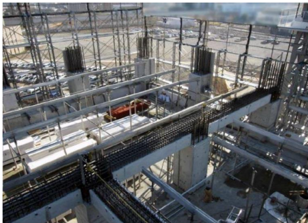
写真6 柱梁仕口接続型
