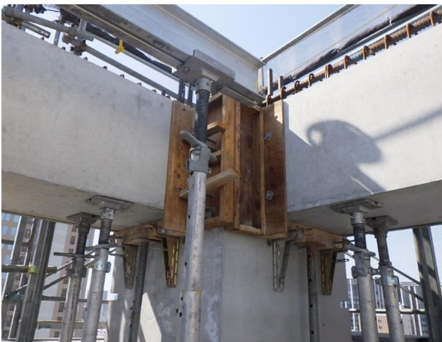
写真11 柱仕口部型枠
