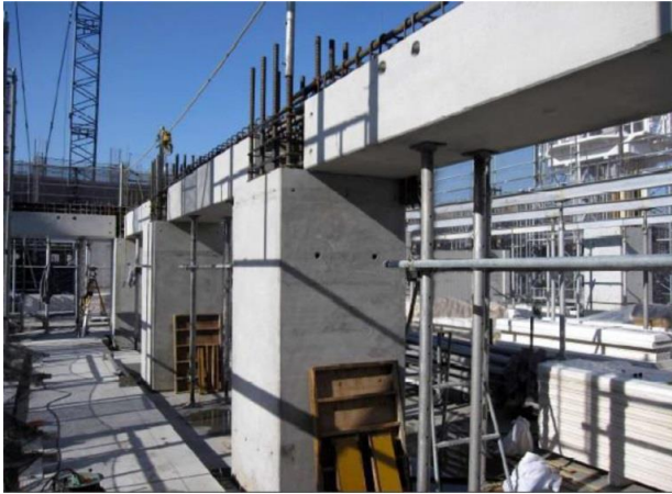
写真1 柱梁仕口接続型
