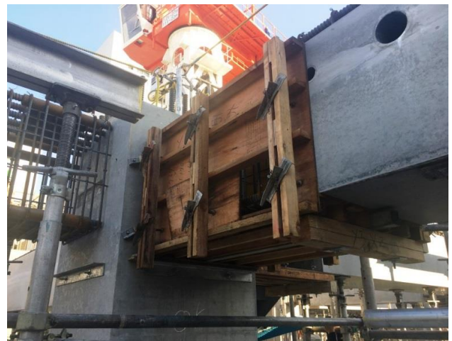
写真12 梁継手部型枠
