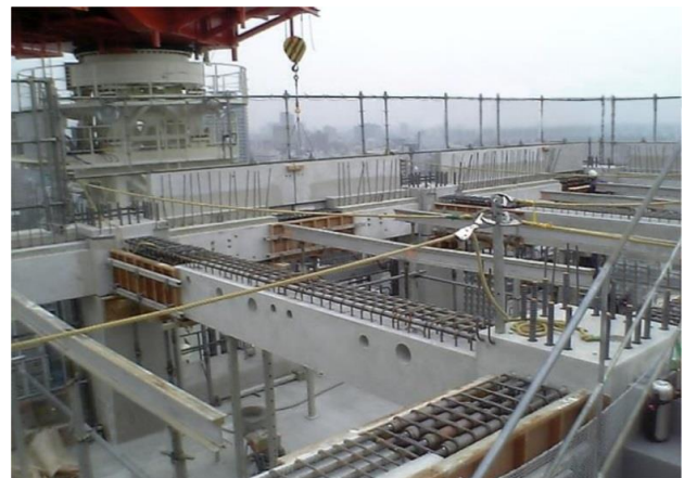
写真7 柱梁仕口一体型
