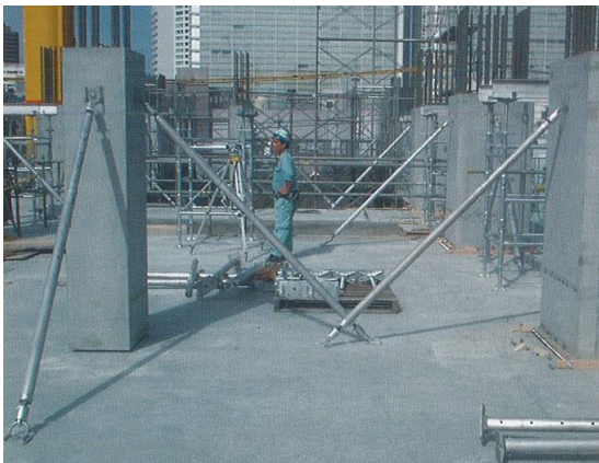
写真9 柱建ち直し用サポート 1)
