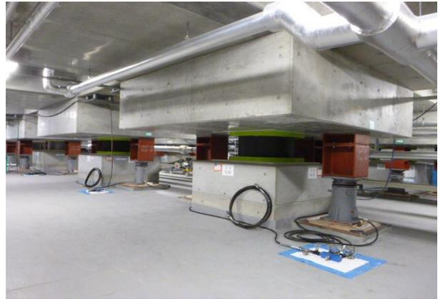
写真2 免震部材交換状況
