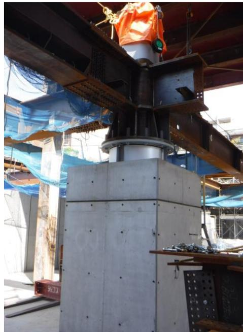
写真10 免震上部鉄骨建方
