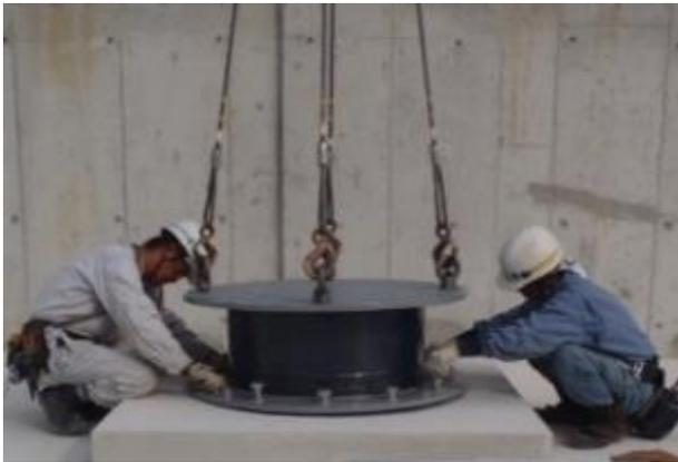
写真17 アイソレータの据付け状況
