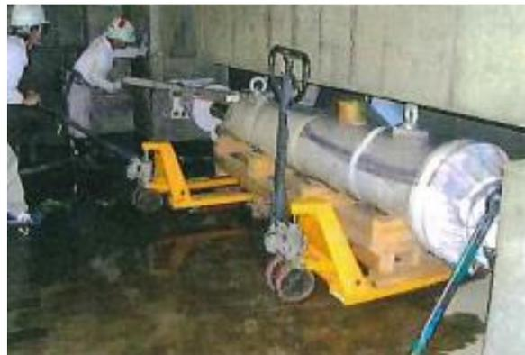
写真24 粘性ダンパーの設置状況<sup>3)</sup>
