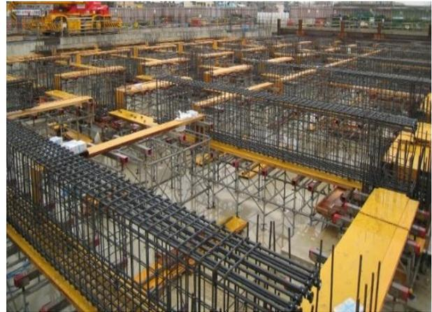
写真5 免震基礎上部基礎の配筋
