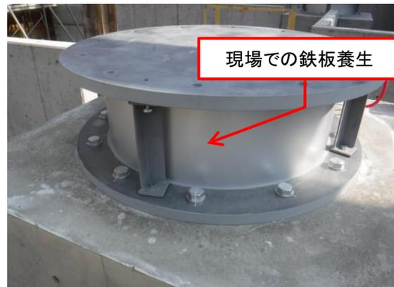
写真2 現場での鉄板養生例
