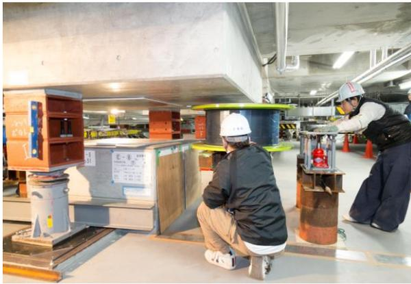
写真1 既存の免震部材取外し状況
