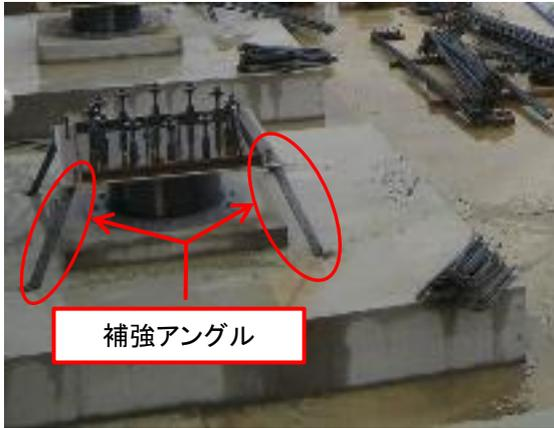
写真3 補強アングルによる拘束
