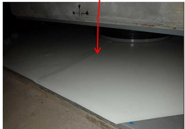
写真20 竣工前の防塵カバーの施工事例<sup>2)</sup>
