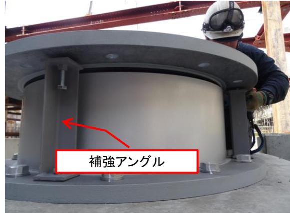
写真4 補強アングルによる拘束
