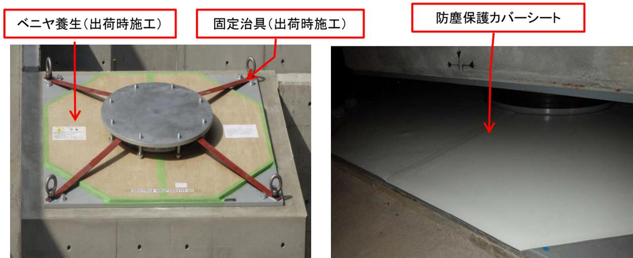
写真19 弾性すべり支承据付け後の養生例
