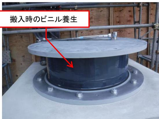
写真1 アイソレータの据え付け時の状況
