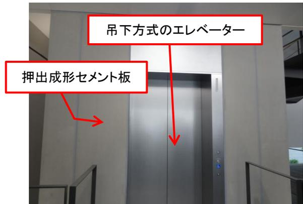
写真40 吊下げ方式のエレベーター
