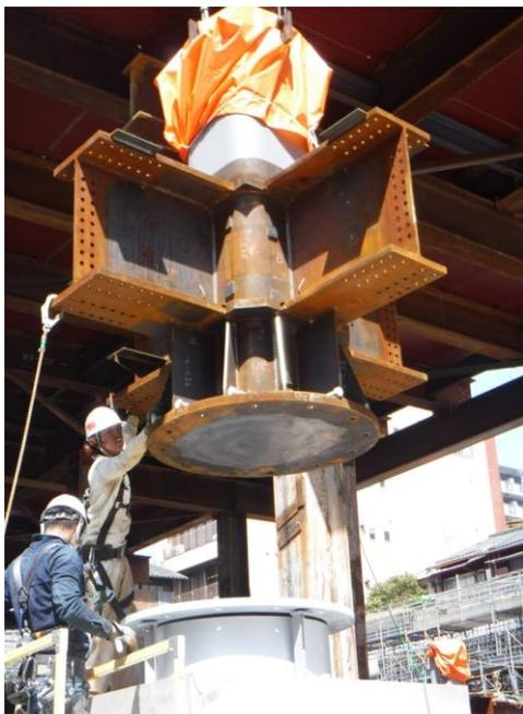
写真9 免震上部鉄骨建方
