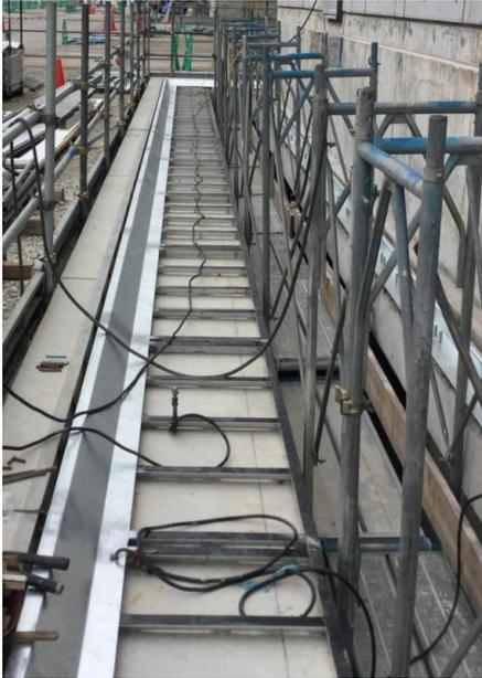
写真29 免震EXP.J金物の施工状況<sup>4)</sup>
