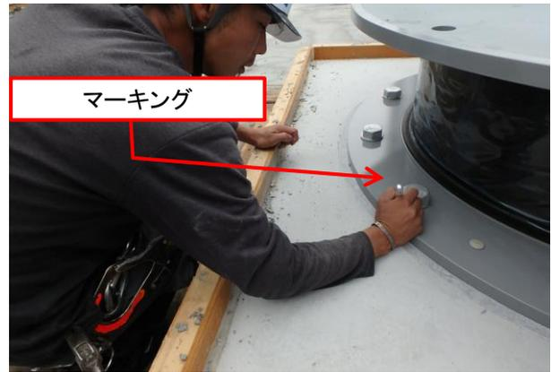
写真18 ボルト締付け完了
