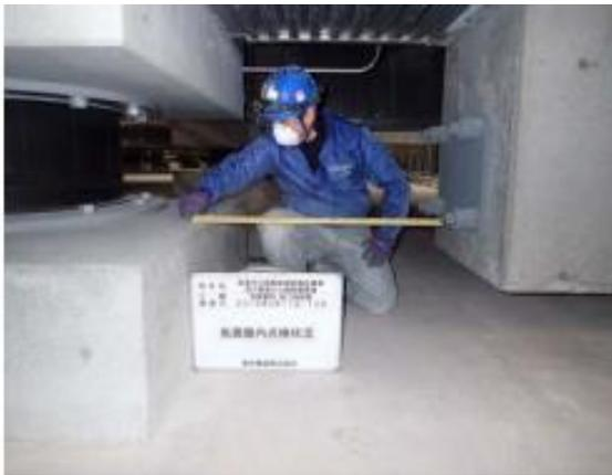
写真25 竣工時障害物検査
