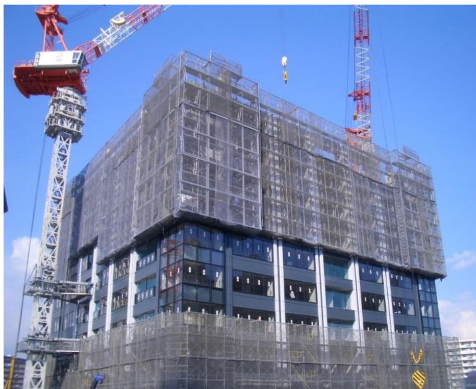
写真14 せり上げ足場 2)
