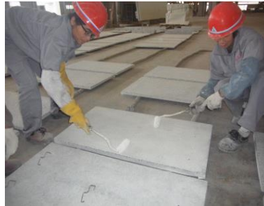
写真10 石材裏面処理 （裏面処理剤塗布）
