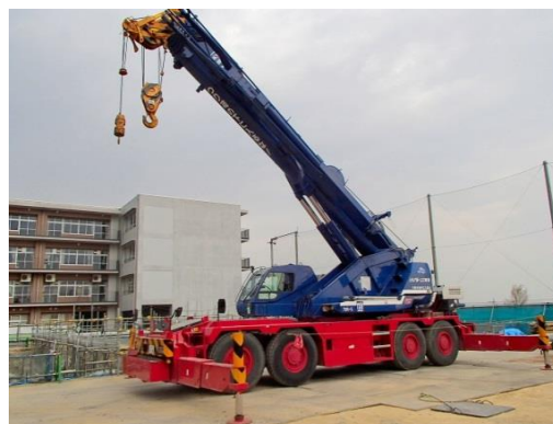
写真8 移動式クレーン
