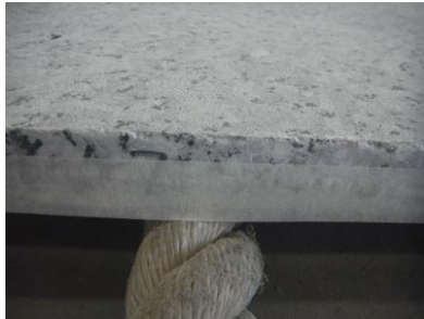
写真9 石材裏面処理 （小口マスキング）
