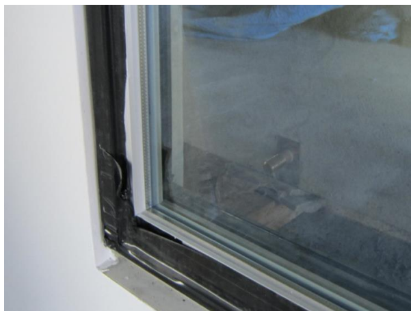
写真2 建具打込み壁PC（詳細部）
