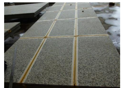
写真14 石目地シーリング施工
