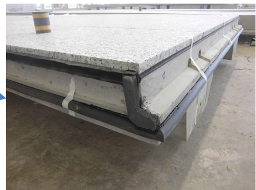
写真4 ガスケット取付け
