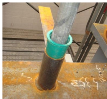
写真10 さや管+手摺支柱 2)
