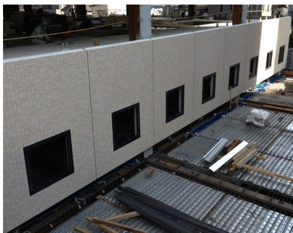
写真1 建具打込み壁PC（全景）
