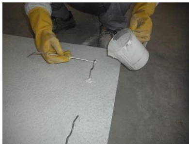
写真12 石材裏面処理 （シアコネクター穴詰め）
