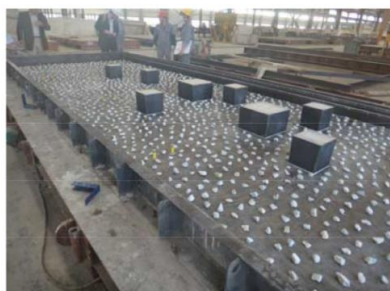
写真15 石材を接着剤で固定
