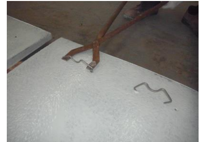
写真11 石材裏面処理 （シアコネクター取付け）
