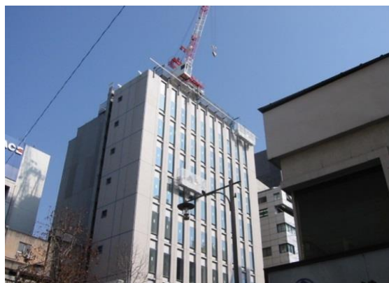
写真12 ゴンドラ足場 4)
