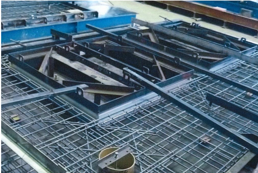
写真18 建具打込み壁PCコンクリート打設前状況
