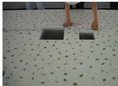
写真16 研ぎ出し完了
