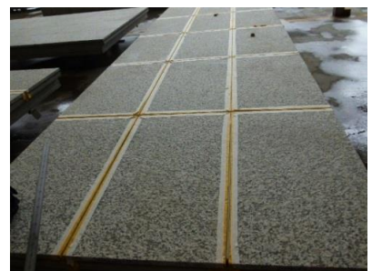
写真14 石目地シーリング施工
