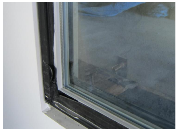
写真2 建具打込み壁PC (詳細部)
