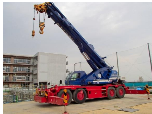
写真8 移動式クレーン
