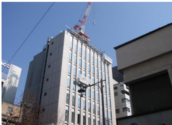
写真12 ゴンドラ足場 4)
