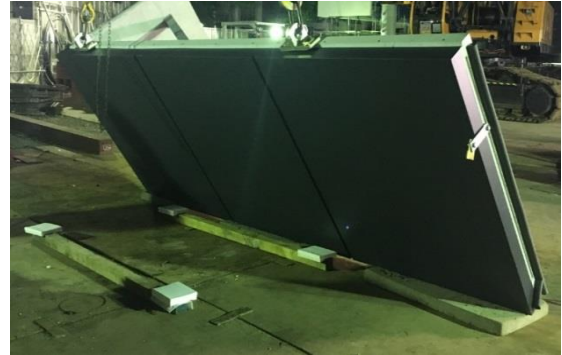
写真4 養生ゴムマット 1)
