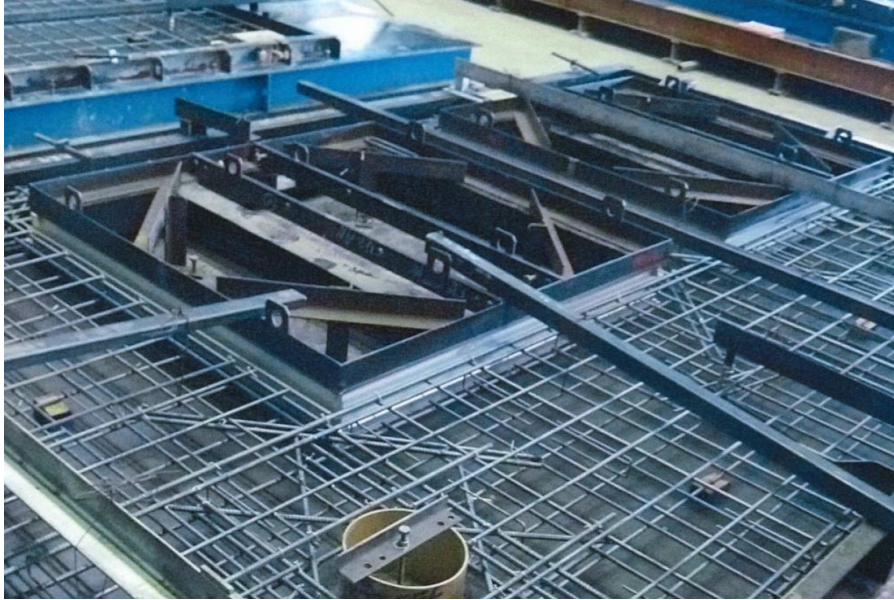
写真18 建具打込み壁PCコンクリート打設前状況 2)
