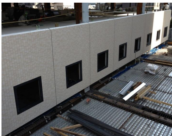
写真1 建具打込み壁PC (全景)
