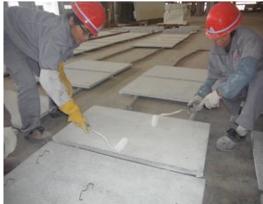
写真10 石材裏面処理 (裏面処理剤塗布)
