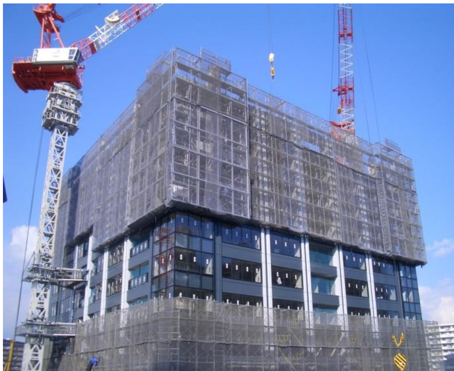
写真14 せり上げ足場 2)
