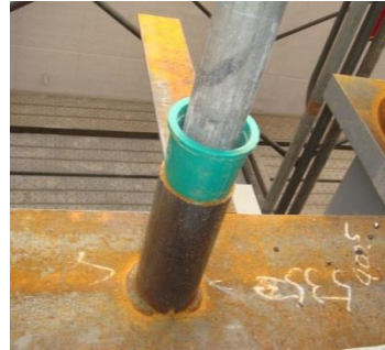
写真10 さや管+手摺支柱 2)
