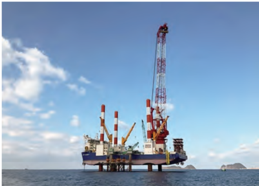
SEP船による風車基礎坑の施工状況(北九州市響灘洋上ウインドファーム)
