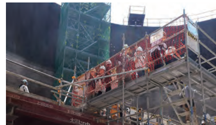
大きなサージタンクの内部へ移動。
