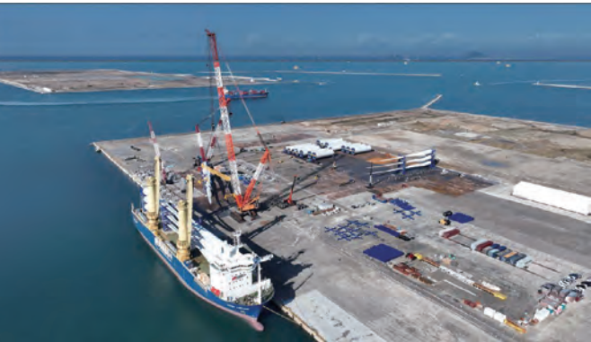
海外で製造された風車部材の受入状況(基地港湾)
