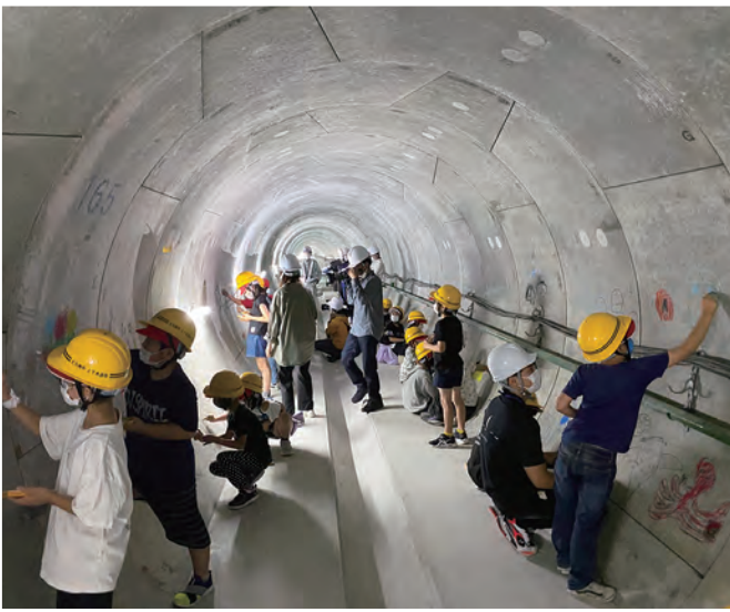
昭和町雨水貯留管
