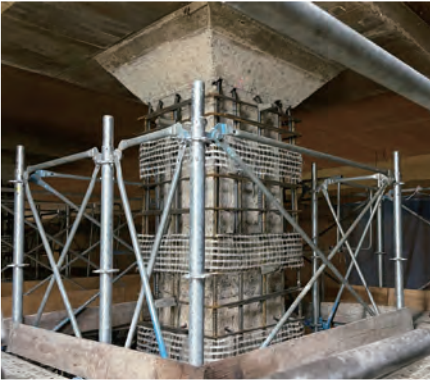
配水池耐震化工事の状況(柱の補強)
