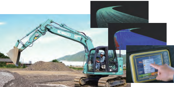
ICT活用工事
