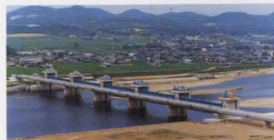
加古川大堰 兵庫県加古川市 加古川の治水・利水機能の向上を目指し、河口から12km地点に総貯水容量196万 m^3 、堤の長さ422.5mの大堰です。
