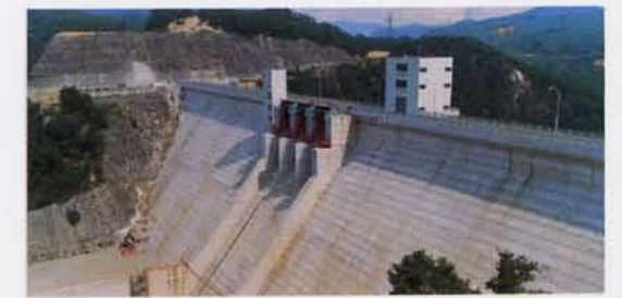
香吐ダム 兵庫県三木市志染町 ダム堤長260m、高さ71.5m、堤体積37万 m^3 で、1886万 m^3 の水を貯水します。兵庫県広域に農業用水、飲料水として供給されます。
