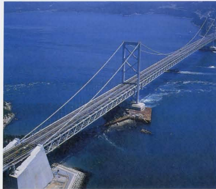
大鳴門橋 兵庫県三原郡～徳島県鳴門市 潮の激しい海峡をまたぐ、全長1,629mの道路・鉄道併用吊り橋（中央径間876m）。世界最高水準をいく技術の結集ともいえます。
