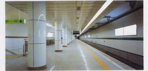
神戸市地下鉄（三ノ宮駅） 神戸市中央区 ユニバーシアード神戸大会開催に向けて、開通。工期の短かさ、クリーム色を基色にした明るい構内等が高い評価を得ています。
