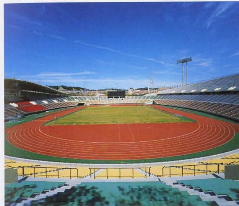
陸上競技場（神戸総合運動公園）'85年ユニバーシアードメイン会場 神戸市垂水区 神戸市の北西部地下鉄で約20分の丘陵地に位置。6万人収容のスタンド、400mトラック・8コースの全天候型の陸上競技場です。
