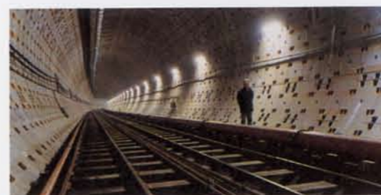
平野川水系街路下調節池（今池シールド） 大阪市東住吉区～平野区西端 都市河川緊急整備事業の一部として建設。木津川平野線の地下20～30mに外径11mのトンネル掘進機を使用し施工しました。
