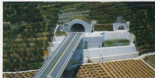
海南湯浅道路（長峰第2トンネル） 和歌山県海南市 本坑（3,831m）から30m離れて避難坑が併行。500mおきに避難連絡坑で結んでいます。当地はミカンの本場。その保護にも注意を払いました。
