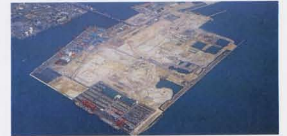
六甲アイランド 神戸市東灘区 総面積は580ha（甲子園球場の約161倍）埋め立て土砂約1億2千万 m^3 。一部は移動しておりますが、全てが完成するのは昭和65年度の前です。
