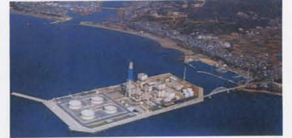
関西電力御坊発電所 和歌山県御坊市 海象条件の厳しい外洋に護岸を建設。その中に人工島（35ha）を、土取、運搬、埋め立ての一貫システムで施工しました。
