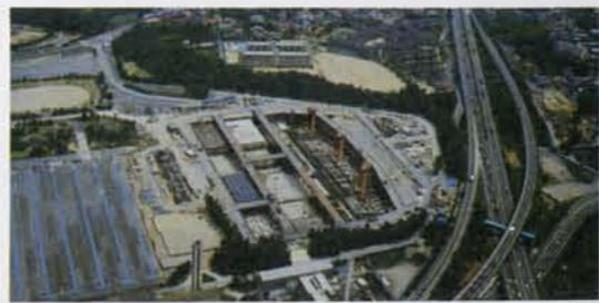
万博浄水場 大阪府吹田市 北大阪地区の給水を対象とする浄水処理施設。陸上競技場を一時撤去して建設し、築造後、約23,000人収容の陸上競技場を復元します。
