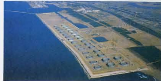
福井石油備蓄基地 福井臨海工業地帯 150haの敷地に、直径82.5m×高さ24mの原油タンク（容量113,000kℓ）を30基。その他、係留施設なども備えています。
