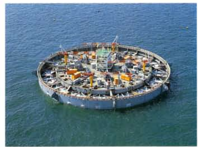
ケーソン設置
