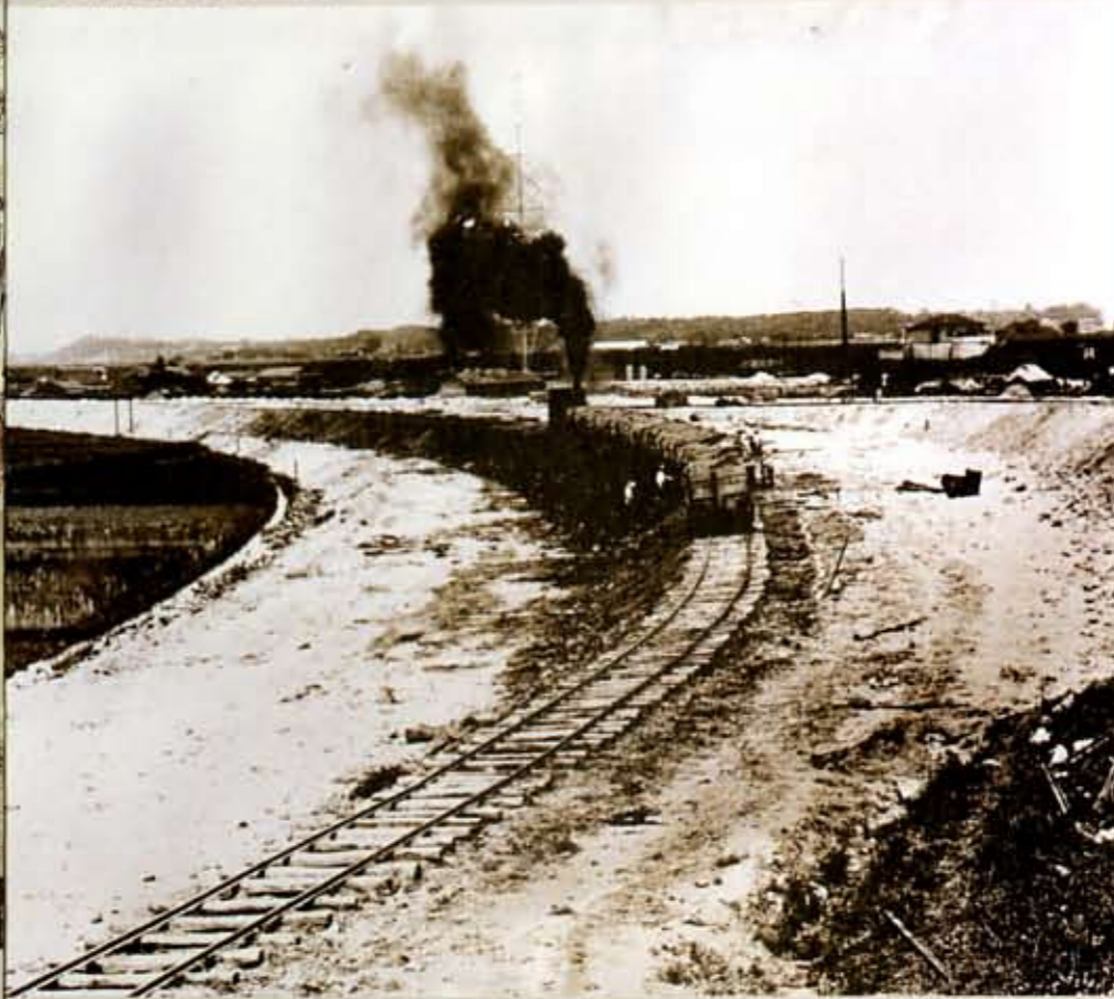
淀川修補工事(昭和14年~43年)
