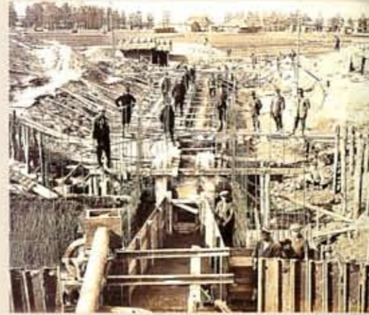
淀川右岸付帯工事(大阪府三島郡島村地先/大正13年)
