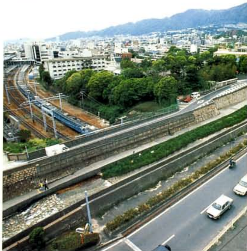
●住吉川の下を通るJR東海道本線、六甲山系の典型的な天井川である。
