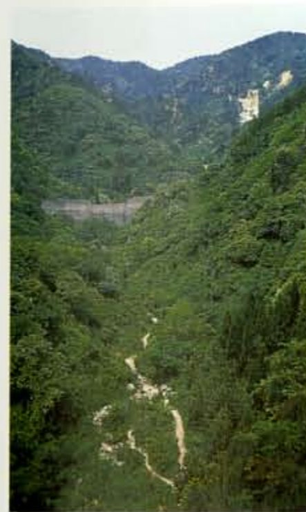
●本庄砂防ダム（住吉川） 昭和44年に完成した高さ20mの砂防ダム。
