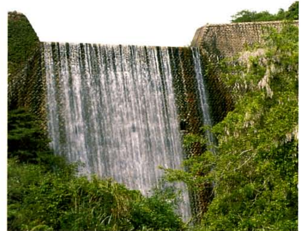
●歴史的施設・五助砂防ダム。 昭和32年に完成した砂防ダムで、昭和42年災害では12万m 3 の流出土砂をくい止める効果を発揮。住吉川下流の安全を確保した。
