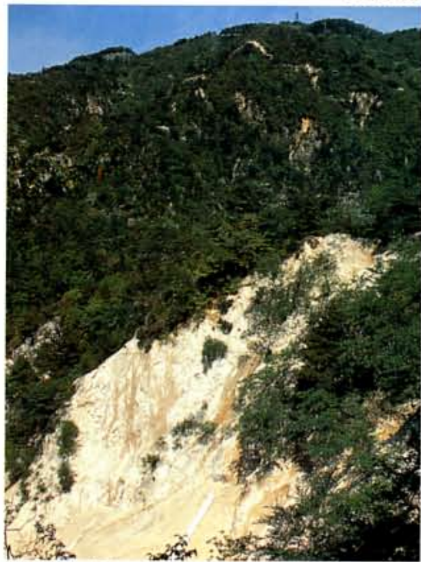
●住吉川上流の崩壊地。六甲山系は大部分が花崗岩で形成。断層や亀裂の発達しているところでは風化が進み脆くなっている。
