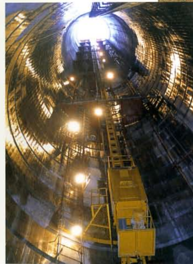
深礎工内部から、地上方面を見る。
