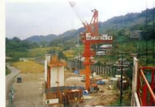
深礎工の工事現場
