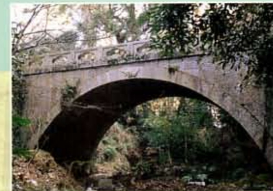
八幡橋（めがね橋）
