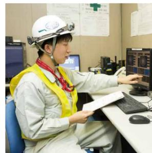
発達基地内のモニターで掘進スピードや圧力などを集中管理
