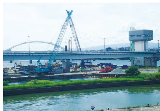
舟運の復活に向けて整備中の淀川大堰閘門
