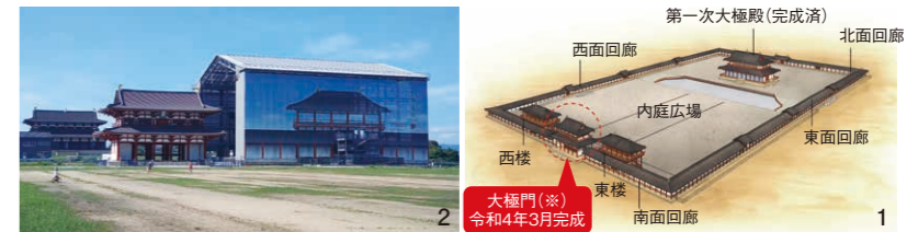
1.東楼・西楼とともに第一次大極殿を囲う回廊の復原も計画されている。2.素屋根に覆われた大極門隣りでは、「東楼」の復原工事が始まっている。
