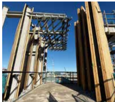
モックアップを製作して仕上げや施工手順を確認し、課題を洗い出した。
