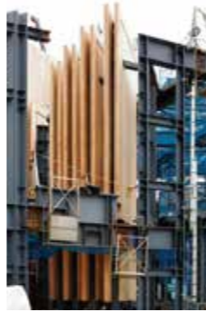
鉄骨建方とCLTパネルの取り付けを同時に進めることで、工期を短縮している。
