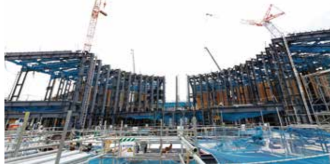
鉄骨建方とCLTパネルの取り付けを同時に進めることで、工期を短縮している。
