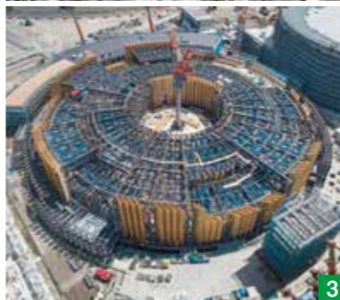
1 掘削・基礎工事とモックアップ工事が進む(2023年11月29日) 2 基礎トラス鉄骨梁工事と設備機器の搬入が進む(2024年4月25日) 3 鉄骨建方とCLT取付工事が進む(2024年8月28日)
