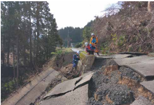
能登半島地震時に寸断された道路
