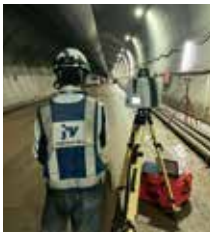
3Dスキャナーによるスキャニングで、覆工コンクリートの施工管理時間を大幅に短縮した。
