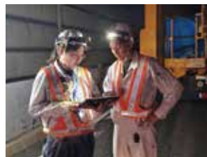
夜間の道路補強・補修作業
