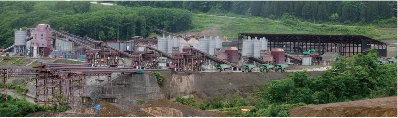
CSGが製造されているプラント。ここで製造されたものが55t積級重ダンプや搬送ベルトコンベアでダム堤体へ送られる。
