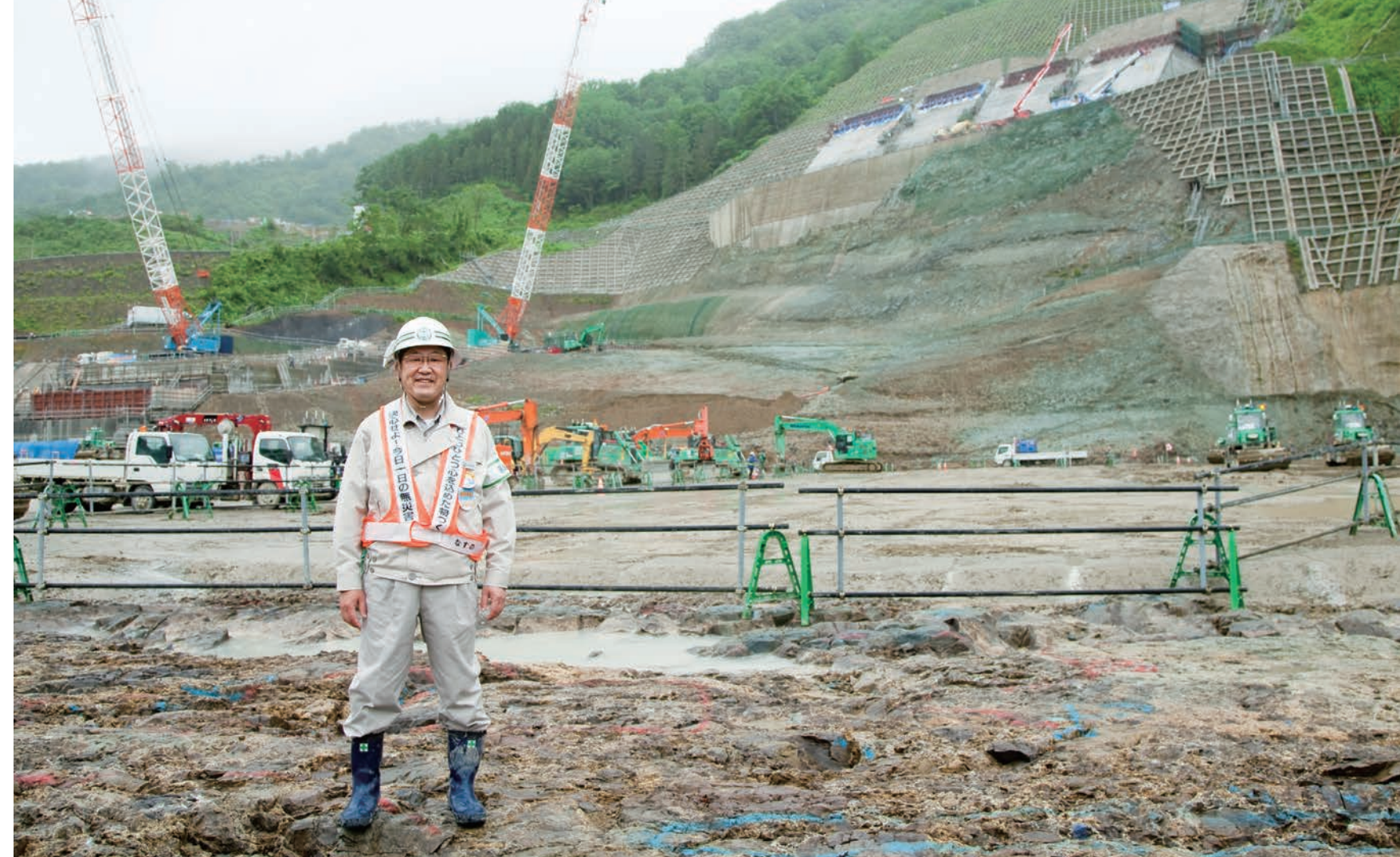
現場を統括するのは、鹿島・前田・竹中土木特定建設工事共同企業体の奈須野 恭伸所長(鹿島建設)。 これまでに全国各地のダム現場を担当してきた、ダム工事のスペシャリストだ。
