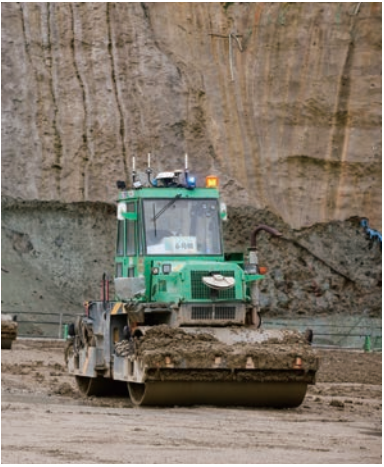
自動ブルドーザーがCSGを敷きならし、写真の自動振動ローラーがCSGを転圧していく。「A 4 CSEL」は専用の自動機械を使うのではなく、汎用の建設機械にGPS、ジャイロ、レーザースキャナなどの計測機器及び制御用PCを搭載し、自動機能を付加しているところも特徴。
