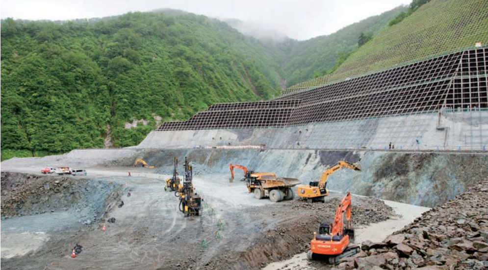
原石山での工事施工中、想定以上に廃棄岩が多かったため、ボーリングを見直し、掘削ラインを57m前に出すことに。この変更によって60万㎡ほどの廃棄岩を省略し、コストカットにもつながったという。
