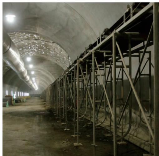
トンネル内に設置されたずり搬出用のベルトコンベア。ずりを運搬する車両などの往復の数が減少できるため、事故や粉塵の発生を抑えることができる。
