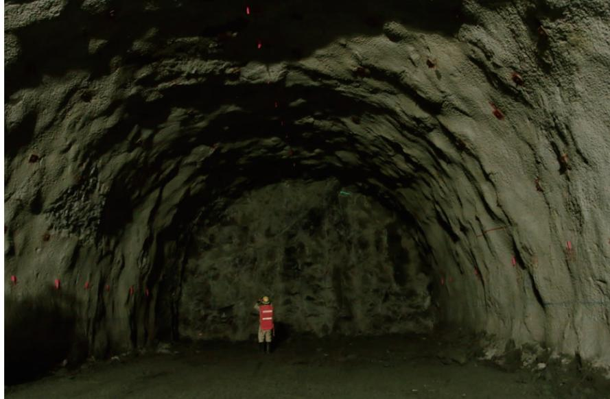
3つのトンネルの中で最も長い延長1,893mを誇る3号トンネル。この区間の地盤には非常に硬い斑礫岩（はんれいがん）が含まれており、コンピュータジャンボなどで削孔するポイントを見極めながら、作業が進められた。
