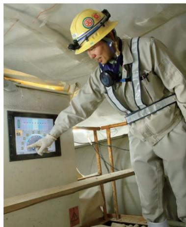
高速道路の工事などで使用されている覆工コンクリートの半自動による締め固めを試験的に導入し、省人化に貢献。
