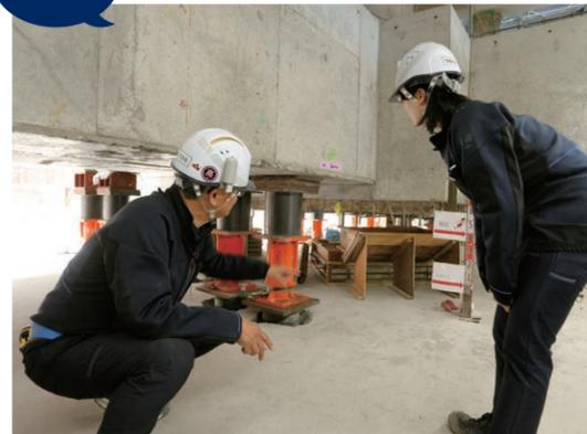
免震装置を据え付けるため、旧庁舎の基礎下を掘削。仮受け装置を使いながら、建物を1か月ほどかけて390mmジャッキアップし、そこに合計41基の免震装置を据え付けていきます。大きな建物を浮かせることに、とても驚きました！
