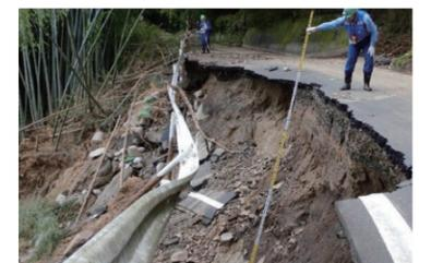
国道349号の丸森町耕野不動から大張川張間の約8kmは、道に沿って流れる阿武隈川の川幅が特に狭いため、水嵩上がりやすい箇所が多く、土砂被害が相次いだ。
