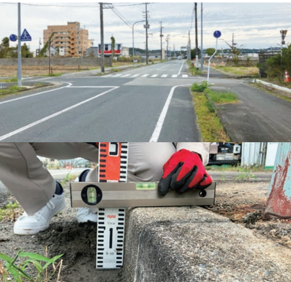
既存の歩道と道路には写真のように段差があるが、整備後は同じ高さにそろえるため、道路をかさ上げする予定。
