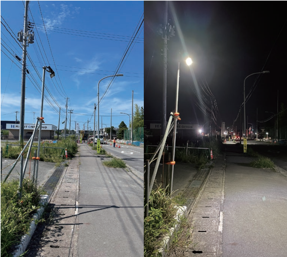
歩道の脇には仮設の街灯が並び、生活者への配慮が窺える。
