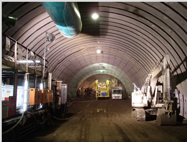
七ツ窪トンネル掘削状況
