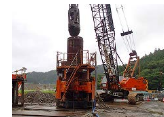
基礎杭：場所打ち杭(φ1.5m)と深礎杭(φ10.8m)
