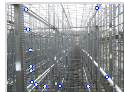
コンクリート打設前(鉄筋組立・パイプ設置完了) ○:鉄筋の間に設置されたクーリング用パイプ
