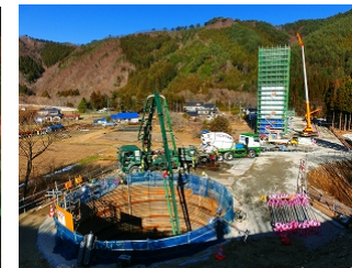
橋脚：施工状況(手前は深礎杭)
