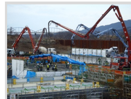
コンクリート打設
