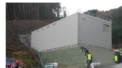
トンネル坑口に防音ハウスを設置
