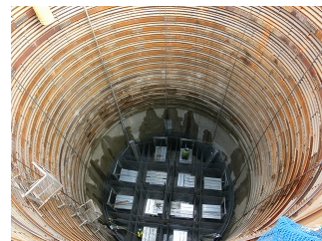
基礎杭：場所打ち杭(φ1.5m)と深礎杭(φ10.8m)
