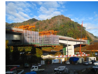
橋桁：張出架設の施工イメージと完成予想図
