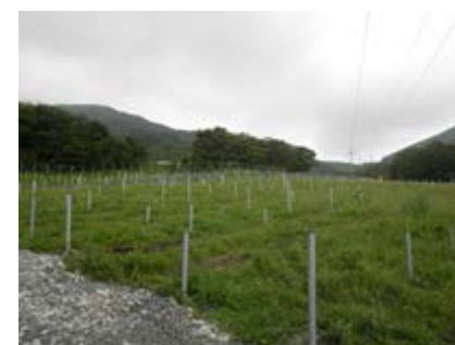
グランドスクリーユ杭施工完了
