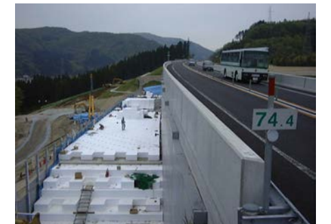
壁構造部分を拡幅する施工例
