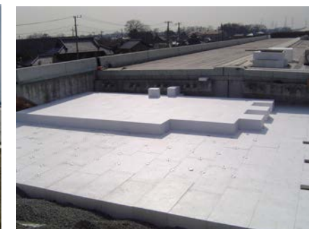
橋の裏側の埋戻し施工例
