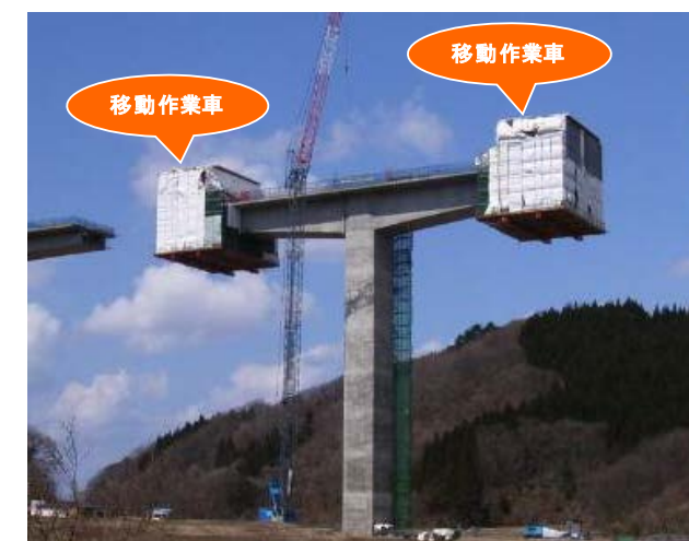
図-2 片持ち架設工法の施工例
