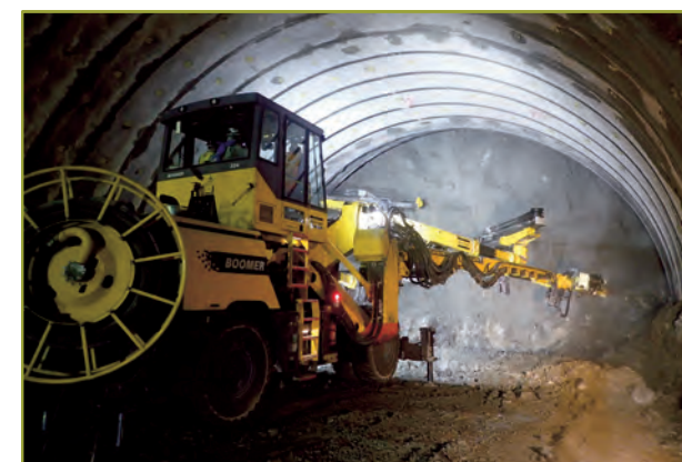
4ブームフルオートジャンボでの施工
