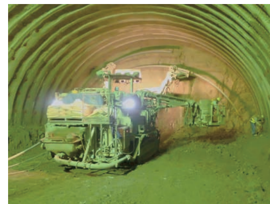
写真-2 トンネル掘削状況
