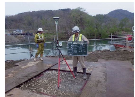
写真-3 橋梁下部 杭芯出し作業状況
