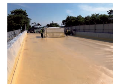
写真-3 床版防水施工
