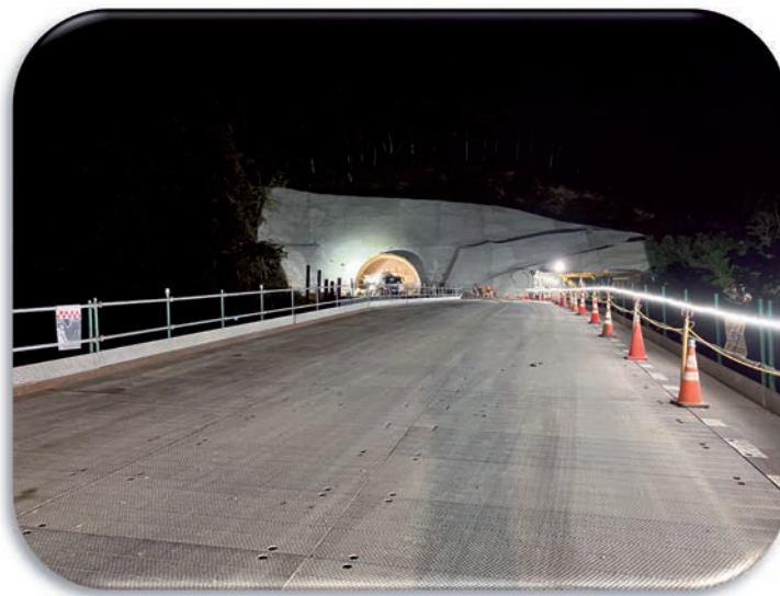
終点側 坑口付近
