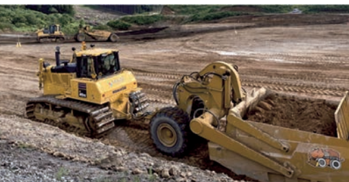
写真・3 安定処理工・土運搬状況
