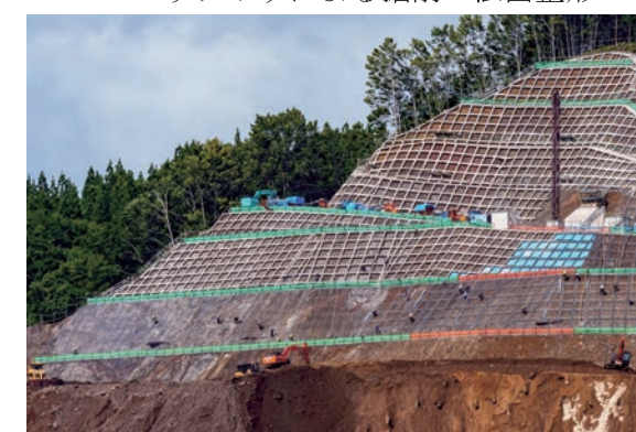
法面保護工を行う作業員
