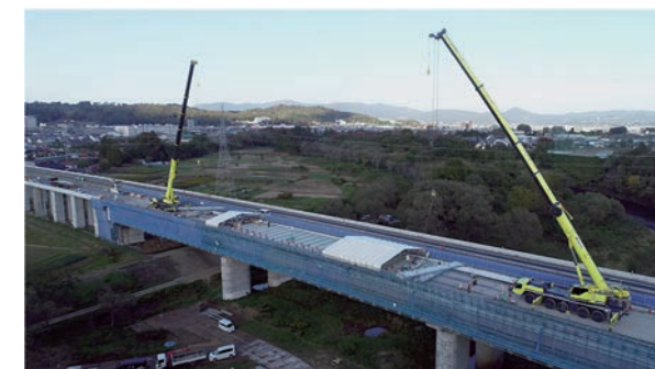
写真-2 床版取替状況
