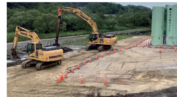
写真・2 地盤改良工【中層混合改良】
