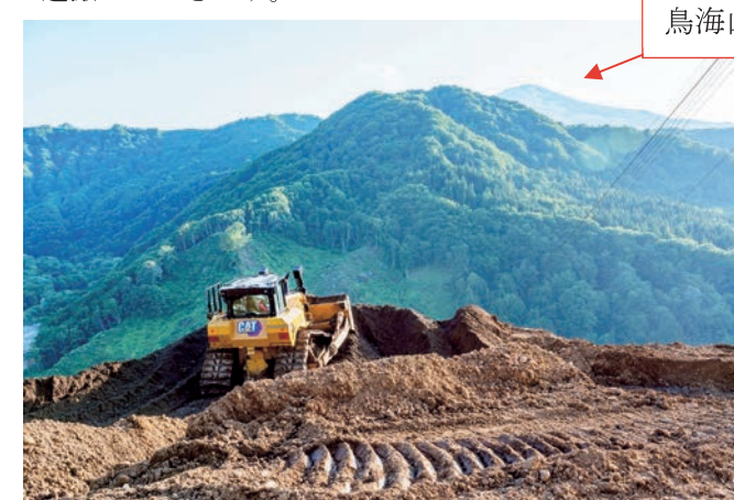
ブルドーザーによる掘削・押土(右奥が鳥海山)
