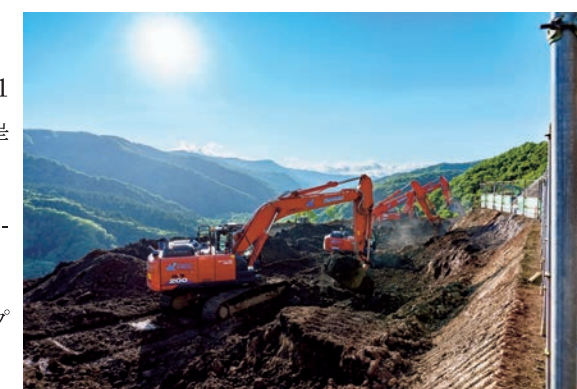
バックホウによる掘削・法面整形
