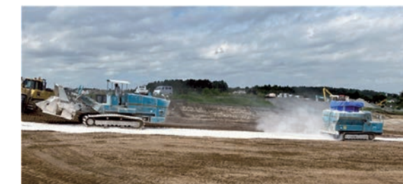
写真・2 地盤改良工【中層混合改良】
