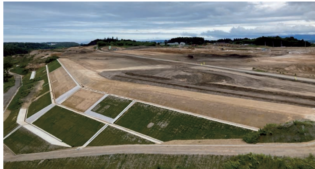
写真・1 八戸北インター第2工業団地
