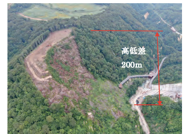
写真・2 右岸側堤体基礎掘削箇所
