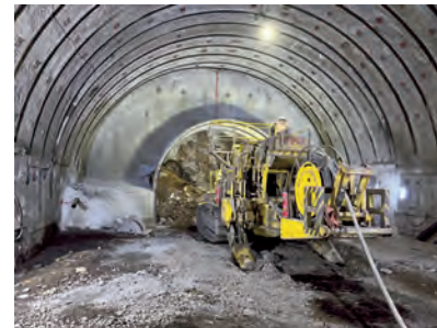
先進導坑掘削状況
