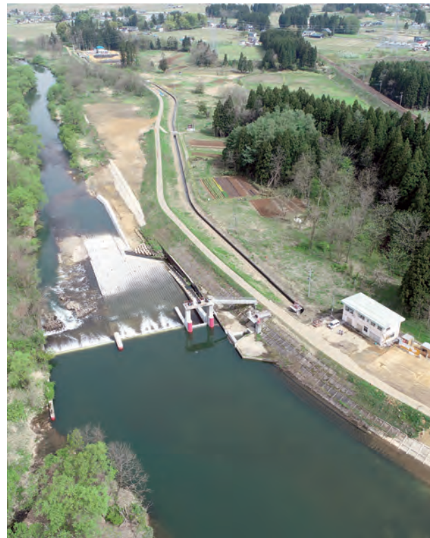
施工状況全景（2024/4/26）
