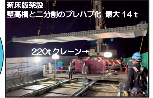
床版の継ぎ目はHead-bar ジョイントを採用し急速で一体化
