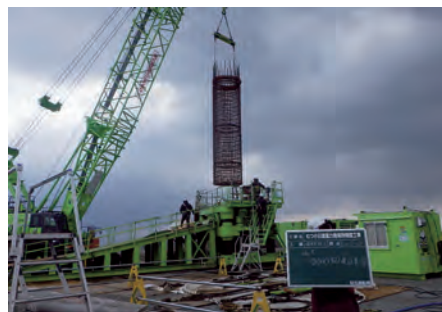
杭鉄筋建て込み状況
