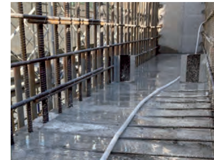
〔写真-3〕自動給水装置
