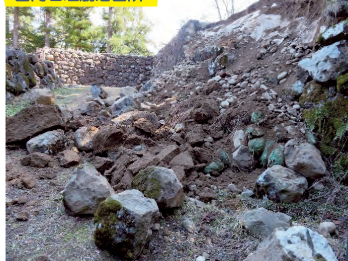
写真-1 福島県沖地震（2022 年 3 月）での被災状況
