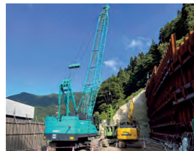
場所打杭掘削状況
