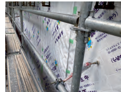
〔写真-2〕湿潤・保温シート
