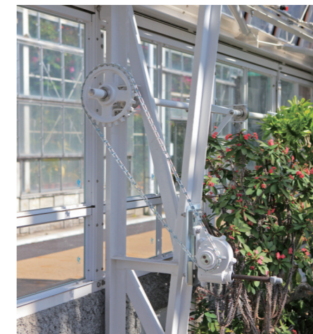
保存修理の際に復元された手動窓開閉装置
