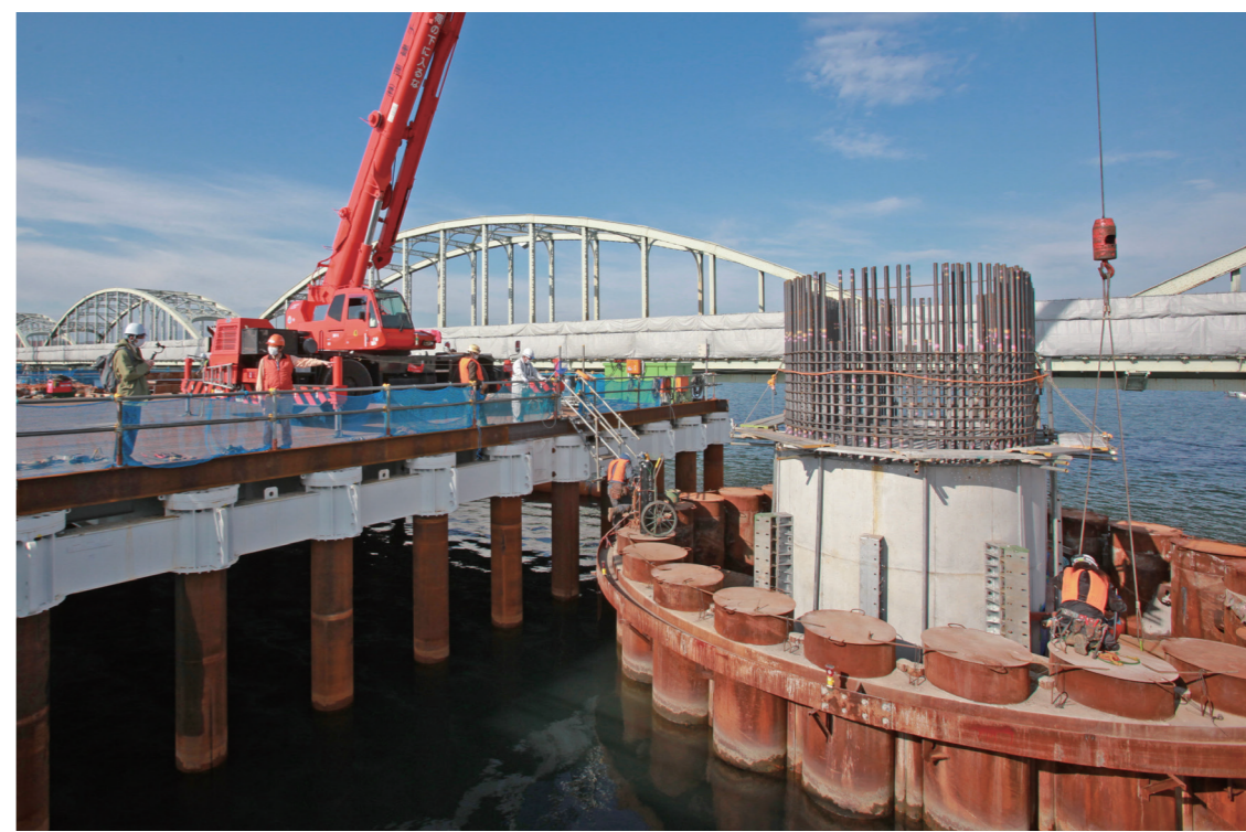
伊勢大橋架け替えの現場
