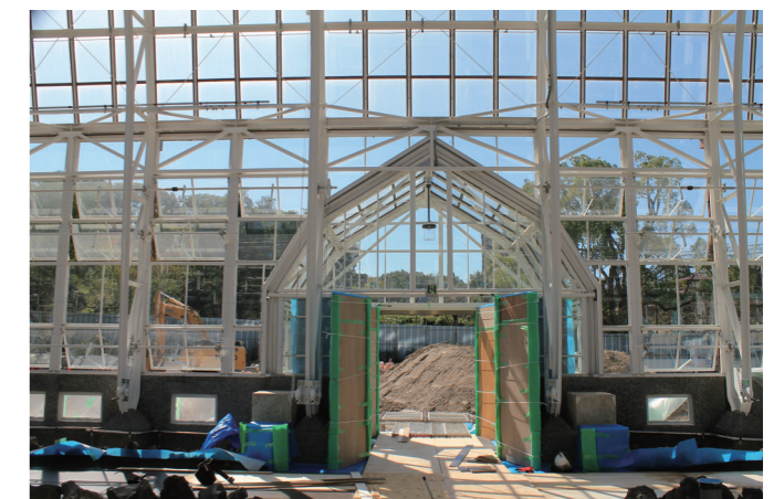
保存修理工事中の温室前館の内観 提供：東山動植物園
