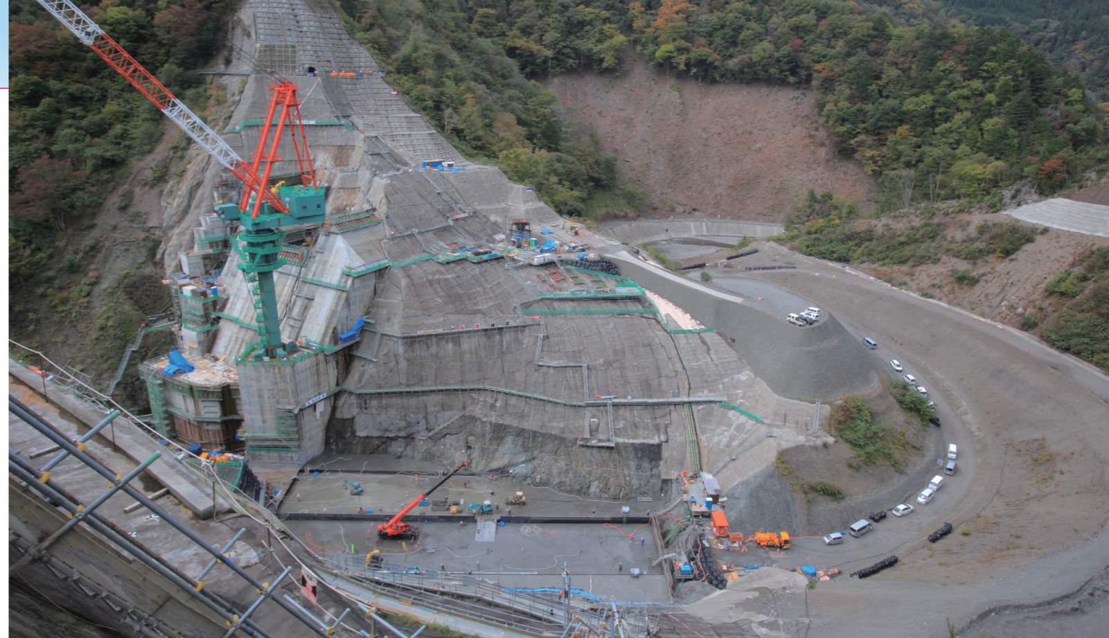
左岸から右岸を望む。堤体のコンクリート打設が行われている
