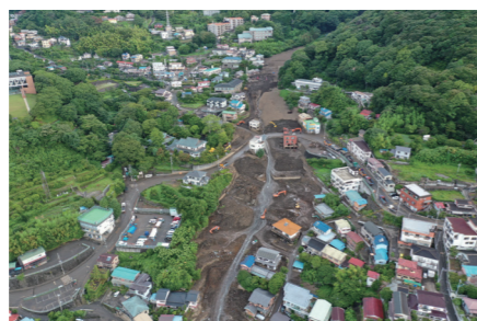
土石流による被害状況
