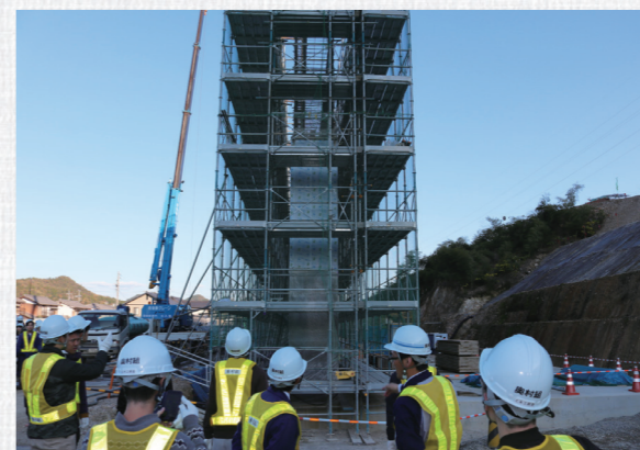
コンクリート高架橋の建設現場を見学
