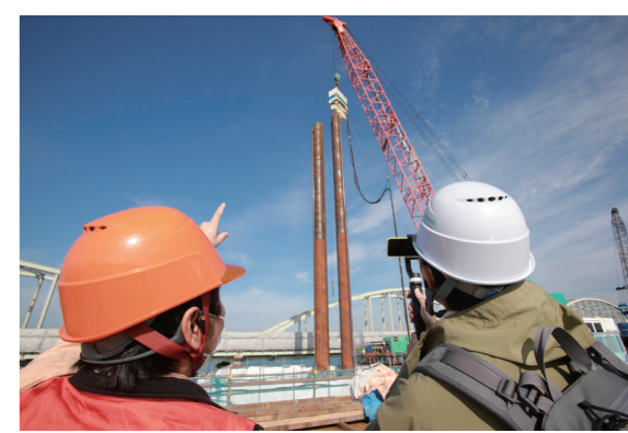
鋼管矢板を油圧ハンマーで打設する様子の中継
