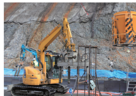
タワークレーンで運ばれるコンクリートバケット
