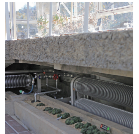
温室を温める装置として、建設当初のものを修理し使用しているギルト放熱器
