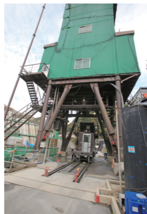
コンクリートの運搬を自動で行うコンクリートトランスファーカ
