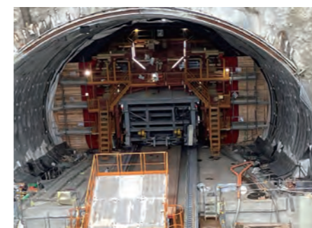
立坑からのぞいた転流工呑口の近景
