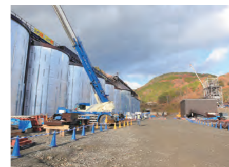
コンクリート製造設備の工事が進む
