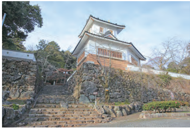
高さ約5mの本丸跡の石垣が残る小倉山城跡
