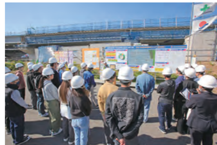
モニターを使った工事概要の説明
