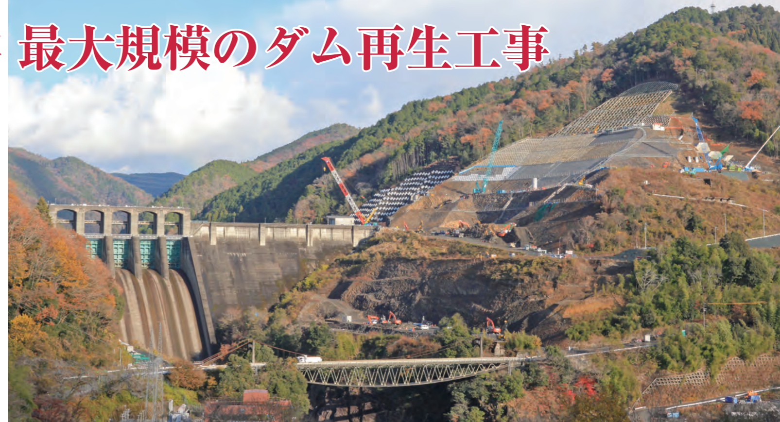
既設の丸山ダム左岸部で進む新丸山ダム基礎掘削
