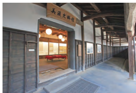
旧今井家住宅内にある蔵を活用した美濃史料館
