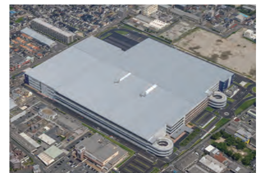
竣工した大規模物流センター
