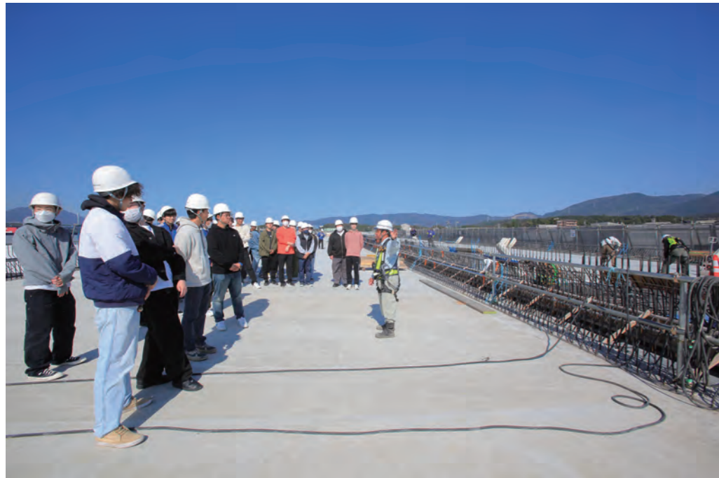
PC桁上で床版や壁高欄のコンクリート強度の説明を受ける
