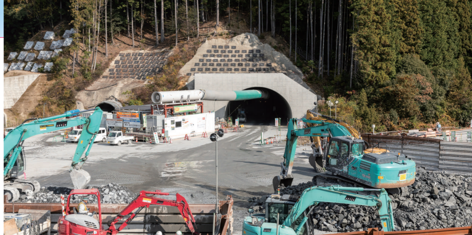
三重県側南工事の坑口とすりを選別する作業ヤード
