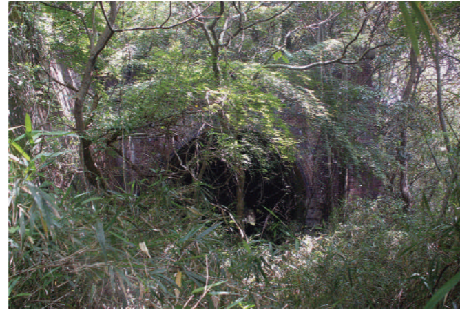
発見当時の3号トンネル。鬱蒼とした藪の中だった
