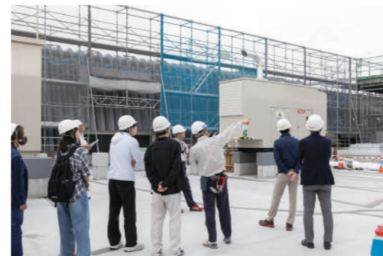
体育館の屋根の取り付けをすぐそばで見学
