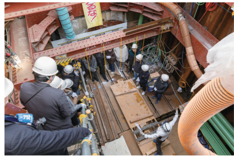
発進立坑から坑内へ進む
