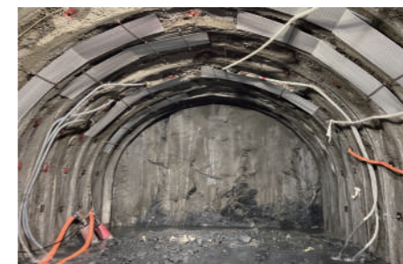
排水ポンプで湧水のくみ上げをしながらの工事
