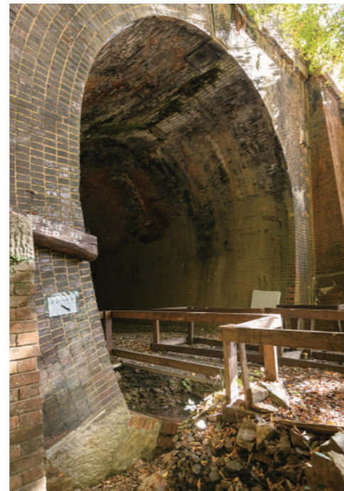
整備された遊歩道の下に全国でも唯一、トンネルの底面補強である「インバート」を見ることができる5号トンネル
