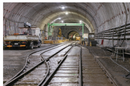
避難坑内に敷かれたレール
