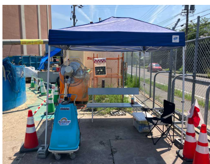
写真④ 現場での対策
