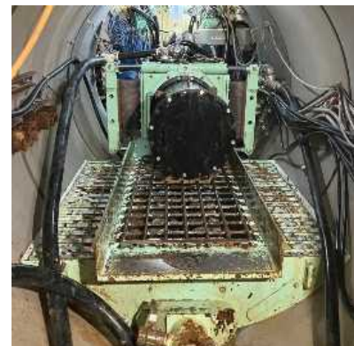
写真② 対策後排泥状況
