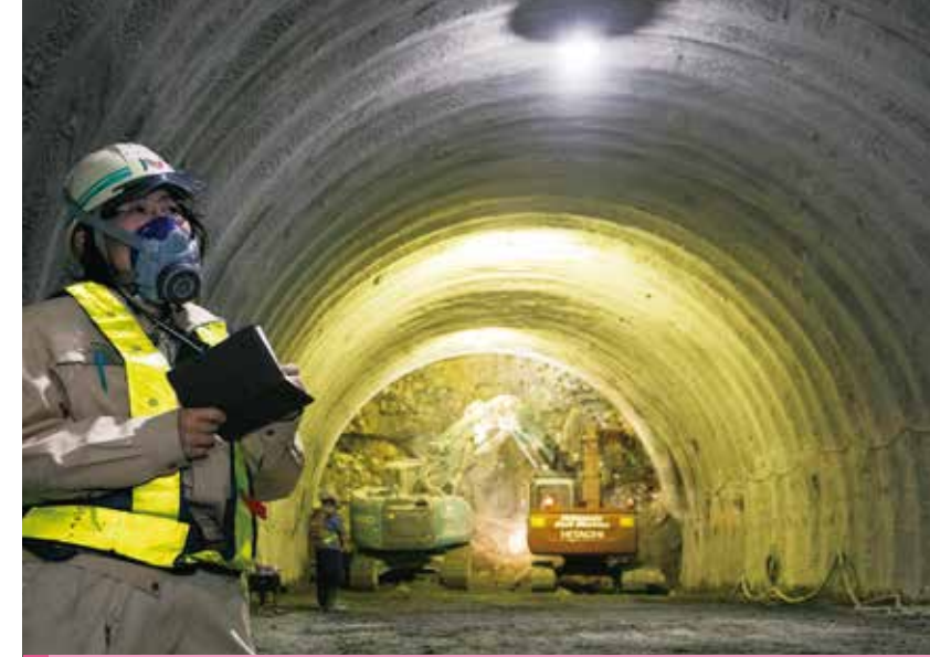
現場は常に変化していくので、ちょっとした変化も見逃さない。常に意識をはりめぐらせて、現場の状況を確認している。
