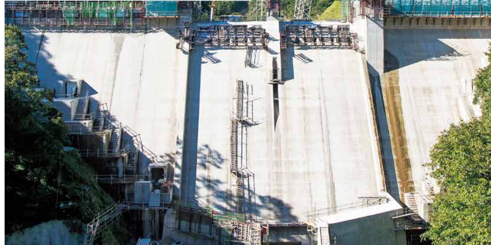
工事名称:庄原ダム 河川総合開発事業 ダム本体工事(公共) / 広島県庄原市川西町上川西 発注者:広島県 施工会社:大林・東洋・伏光庄原ダム特定建設工事共同企業体
