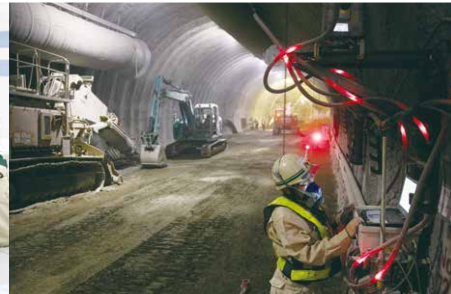
トンネル工事に関するさまざまな情報はパソコンで一元管理している。パソコンを見ながら、的確な指示を出していく。
