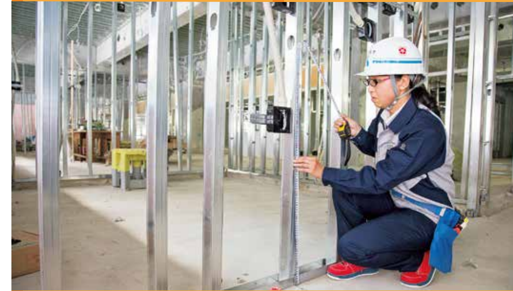
細やかな注意を払って施工箇所をチェック。「設計図面どおり現場が仕上がっていないと、施工全体に影響するので、気が抜けません」と話す高森さん。
