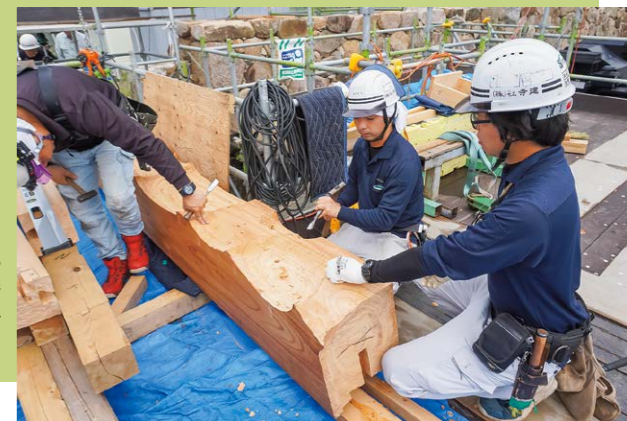
▷石垣に接する寄掛柱は石の形に合わせて少しずつ加工していく
