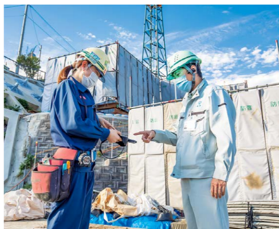
◁工事が正しく進んでいるか、鋼管杭を入れる穴を確認
