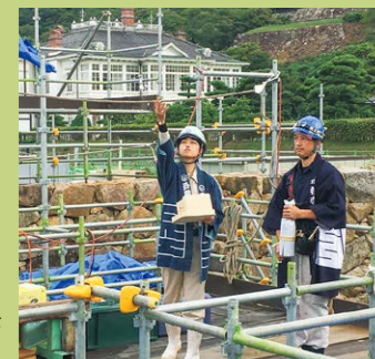
▷柱を立てる前に立柱式を行い、靱い清めを行った
