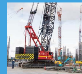
△これから鉄骨建方がスタート
