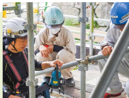
▲測量後に大工さんと現地で墨を確認
