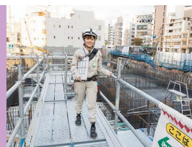
△現場をまわりながら、作業の進み具合をはじめ、危険な箇所がないかチェック
