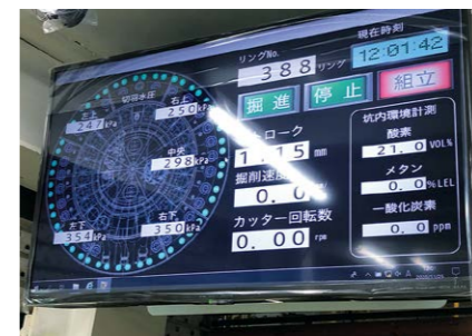
△坑内でも工事の進捗がわかるようにしています
