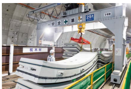
△セグメントを10ピース組み立て一つのリングにつなげることでトンネルになっていく
