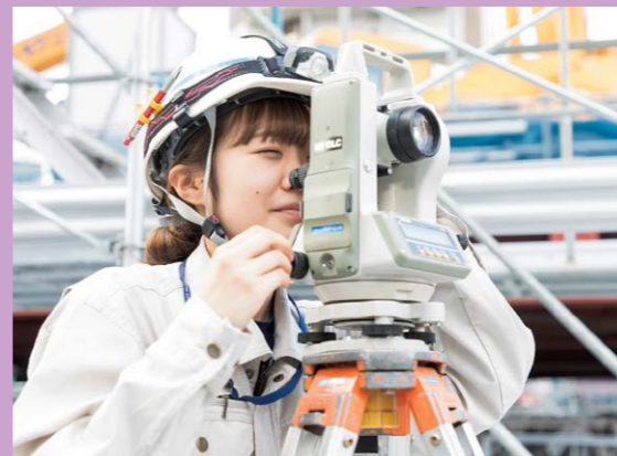
△トランシットでコンクリート打設前のレベルをチェック。日々の細かな確認をすることで、工程が正しく進んでいるかを把握
