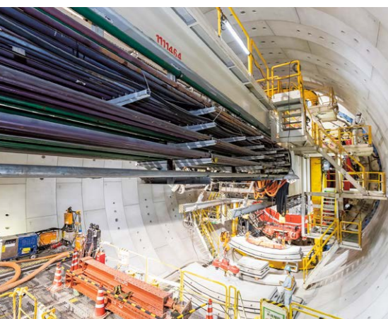
△掘削土砂は土砂ピットに排出。土砂は他の工事で活用されます
