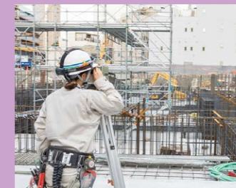
△トランシットでコンクリート打設前のレベルをチェック。日々の細かな確認をすることで、工程が正しく進んでいるかを把握
