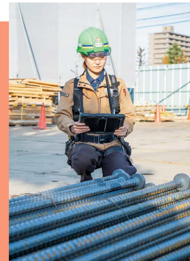
△鉄筋材の仮置き場にて
