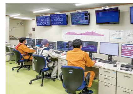
△掘削土砂を含んだ泥水の流体輸送管理、泥水処理プラントの運転管理を行う中央制御室
