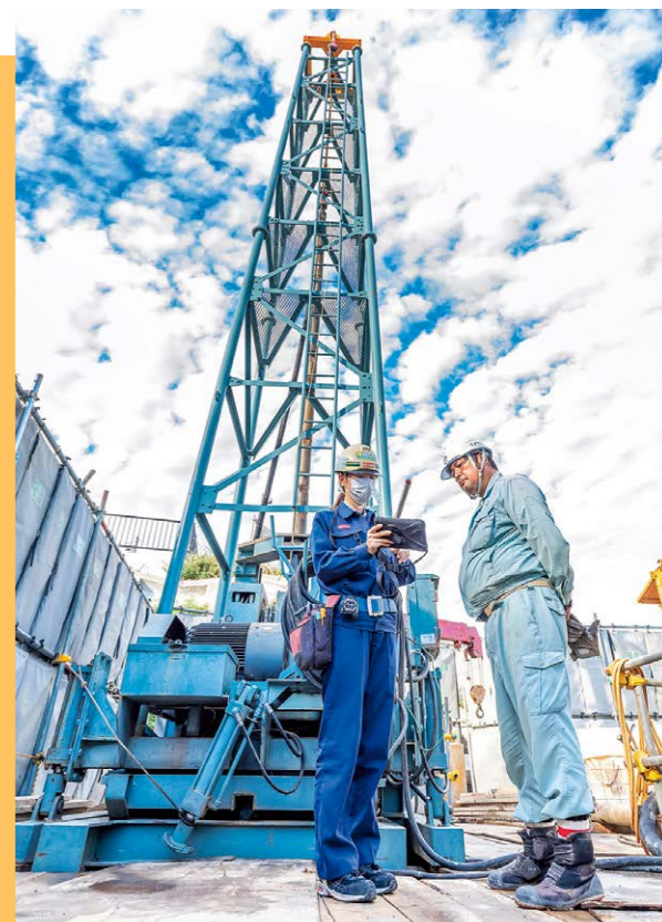
△穴を掘って杭を入れるボーリングマシンの前で職人さんと
