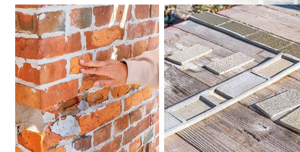
左/内壁のレンガは崩れやすいため、今後対策を講じる必要がある。 右/外壁補修の際、見た目をできるだけ近づけるために、コンクリートと石の混合バランスを検証。
