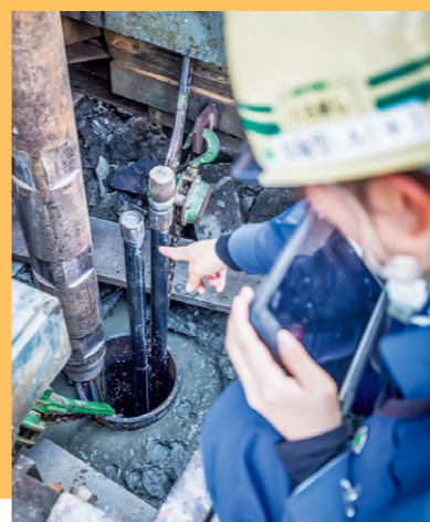
◁工事が正しく進んでいるか、鋼管杭を入れる穴を確認
