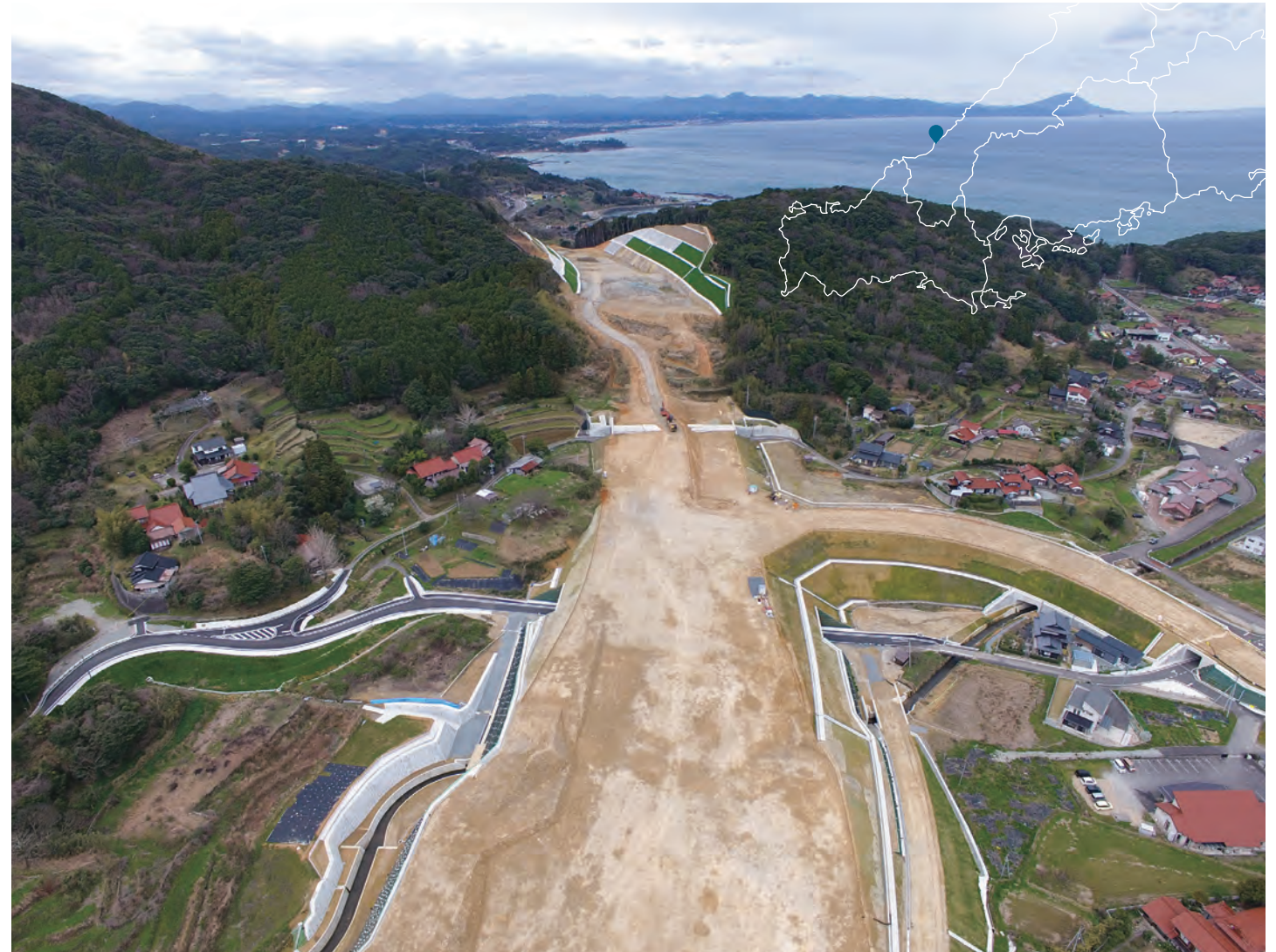
令和2年度三隅・益田道路鎌手IC改良工事 写真提供：国土交通省中国地方整備局
