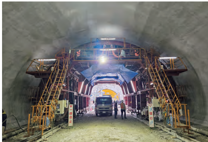
A 令和4年度俵山・豊田道路第1トンネル工事 写真提供：国土交通省中国地方整備局
