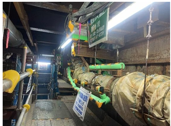
写真2：水道曲管防護
