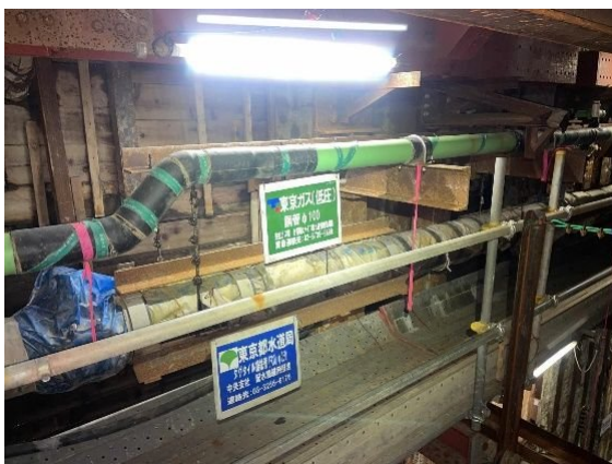
写真1：水道継手防護
