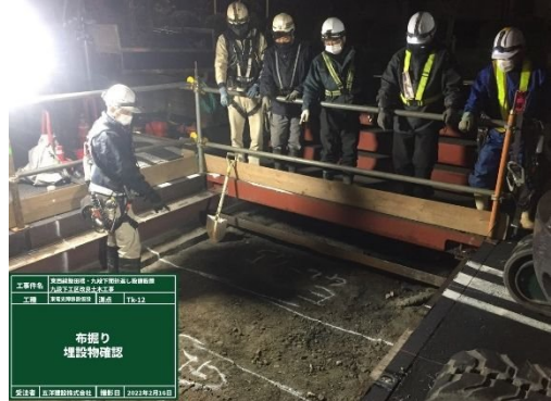
写真8：現地埋設物可視化
