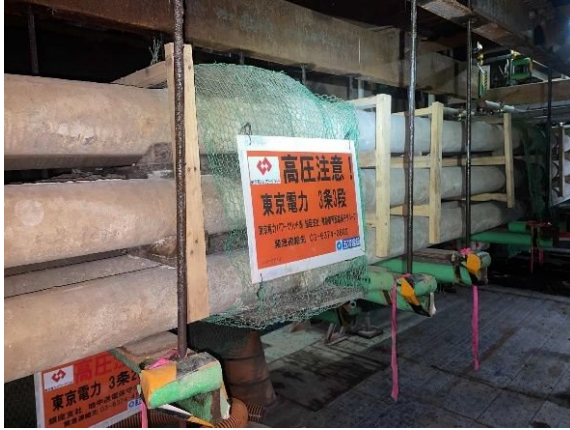
写真3：東電防護コン落下防止養生
