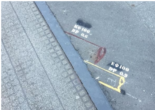
写真7：埋設物路上明示
