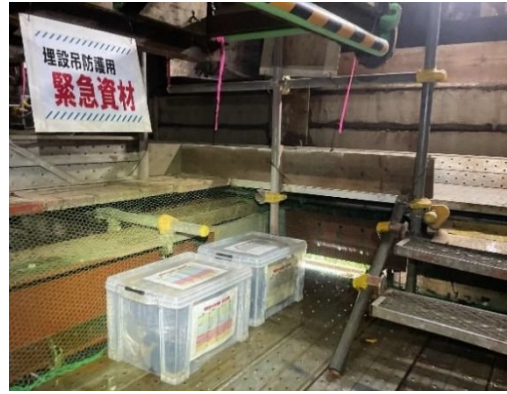
写真6：埋設吊防護用緊急資材
