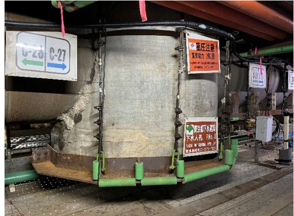
写真4：下水道人孔吊枠構造
