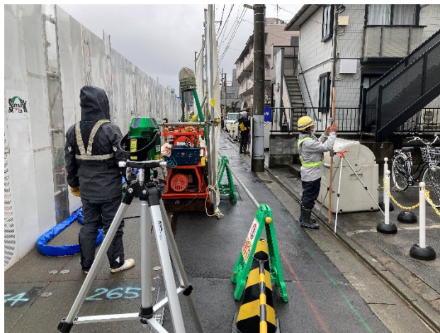
写真-3 薬液注入時の常時変位観測
