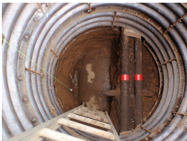
写真-1 深礎工法による試掘
