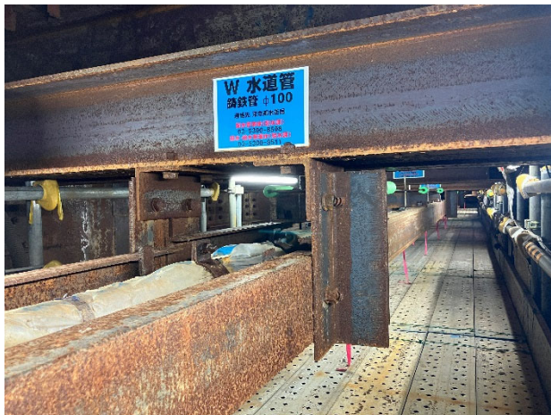
写真-5 駅部西側の埋設吊り防護状況
