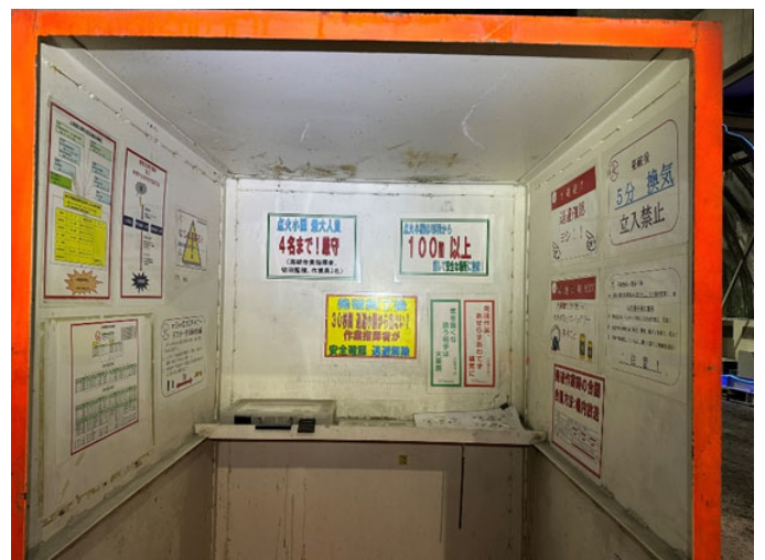
写真-9 点火場所での発破作業時のルール明示
