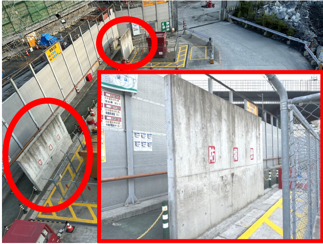
写真-6 取扱所・火工所の防爆壁の設置
