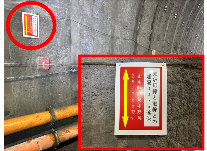
写真-8 発破母線と電線の離隔標示
