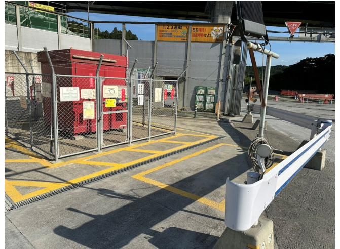
写真-4 保安空地・運搬車専用駐車場の明示
