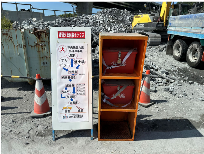
写真-3 不発残留火薬ボックスの設置
