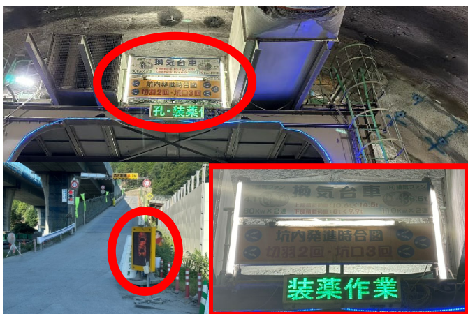
写真-7 電光掲示板による作業内容の周知
