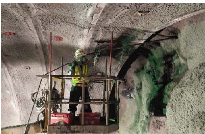
装薬状況(爆薬の遠隔装填システム)
