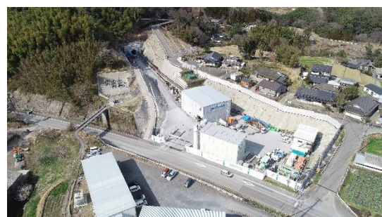
写真-1 仮設ヤード全景
