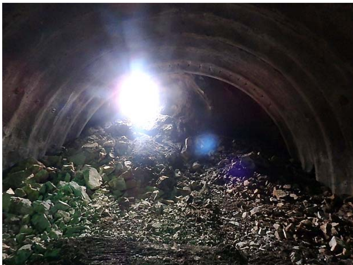
トンネル貫通
