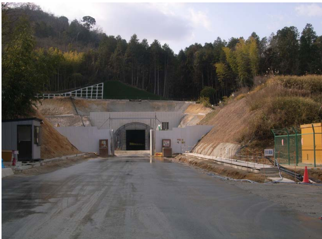
【岩山トンネル黒瀬側坑口全景】
