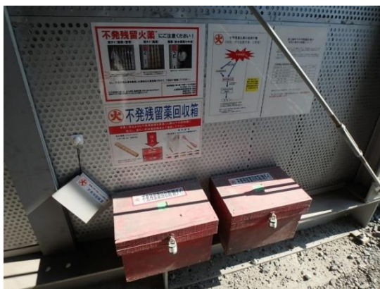
写真-4 残土仮置き場の不発残留対策
