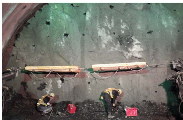
装薬状況(落石防護バルーン)
