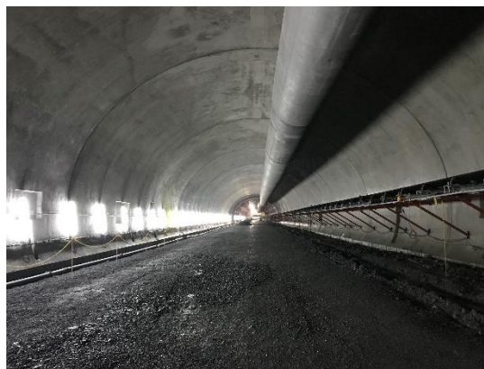
写真-14 覆工完了区間
