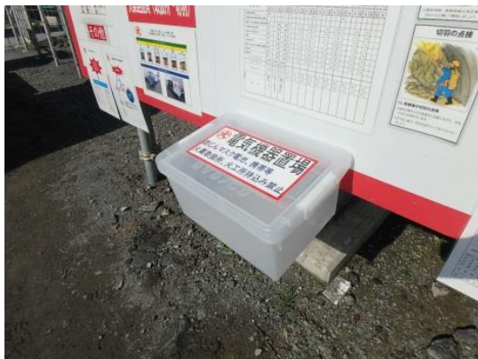
写真-7 電気機器置き場
