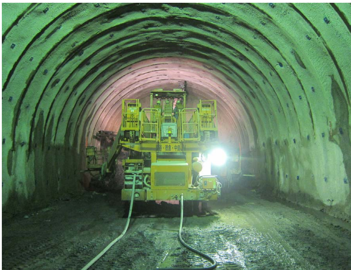
発破削孔状況
