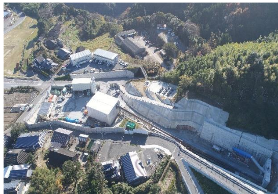
写真-13 坑外ベルトコンベアと防音ハウス
