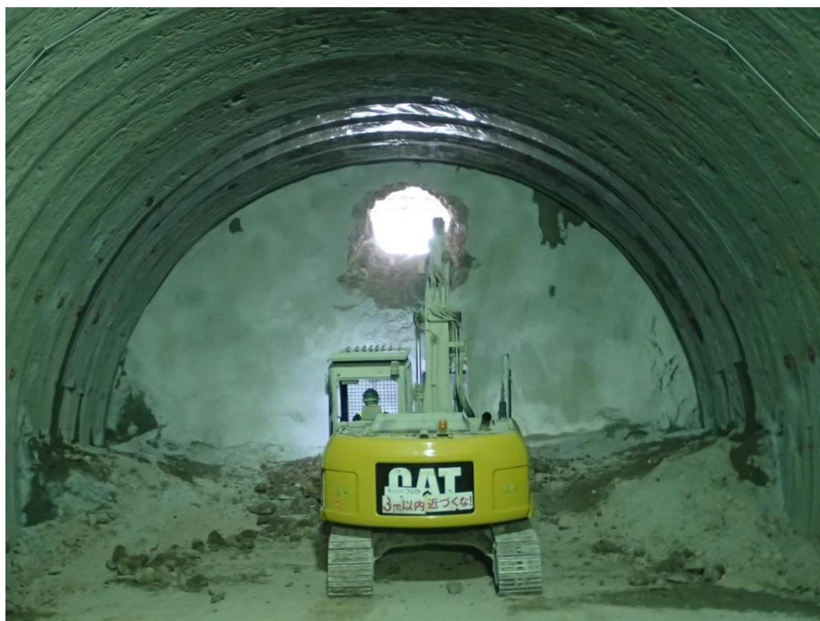
トンネル貫通
