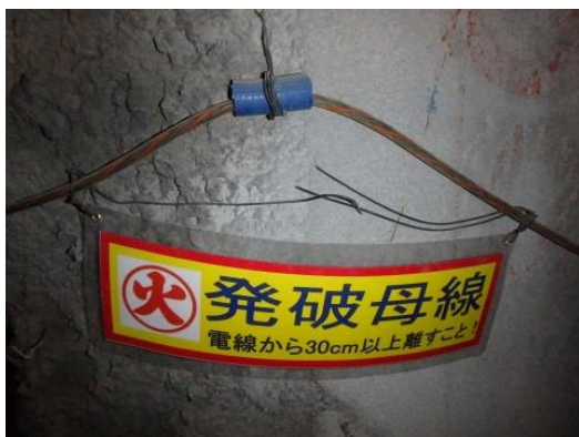
写真-8 発破母線の明示
