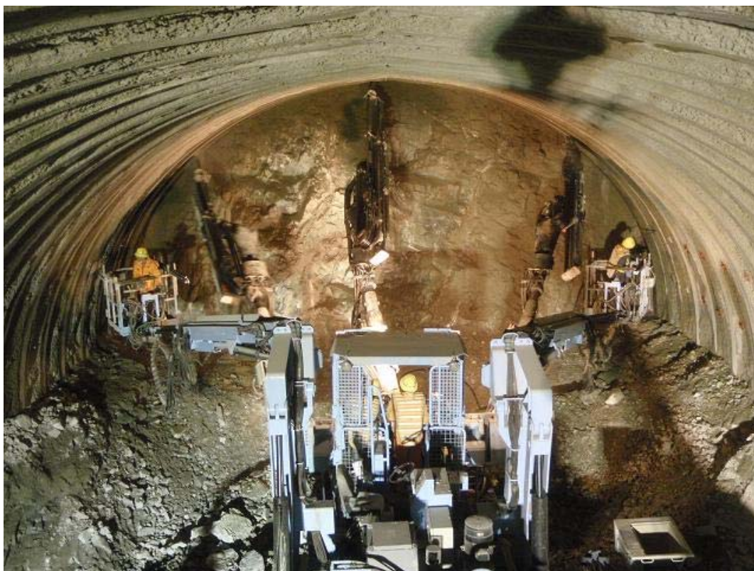
【別所トンネル掘削状況】
