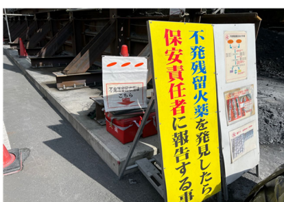
場内残土搬出積込み場 不発残留火薬回収箱
