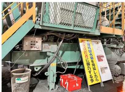
坑内ズリ仮置場 不発残留火薬回収箱
