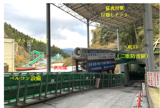
図-2 作業横坑入口部
