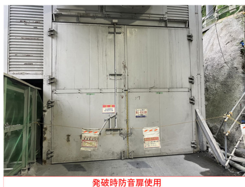
図-21 作業横坑坑口部防音扉
