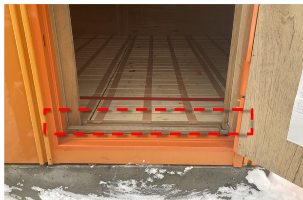
写真－１１ 爆薬庫出入口
