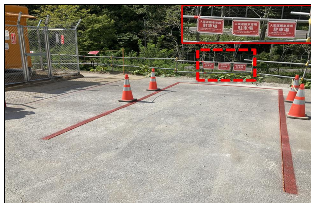
写真－15 火薬運搬車専用駐車場
