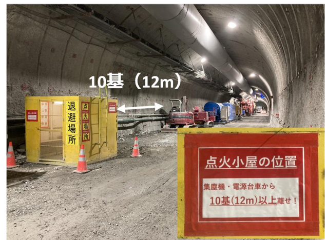
写真－２１ 点火小屋 設置状況
