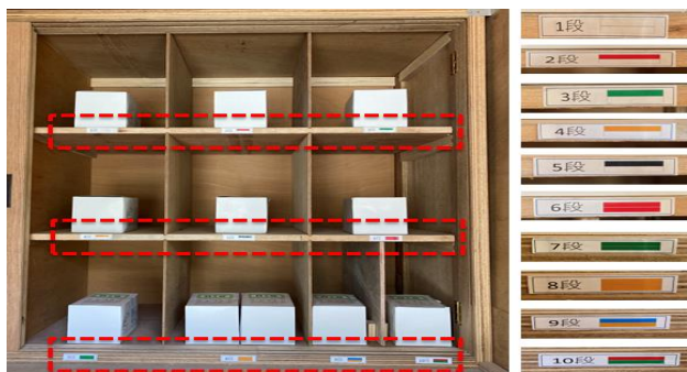
写真－13 電気雷管収納棚の様子
