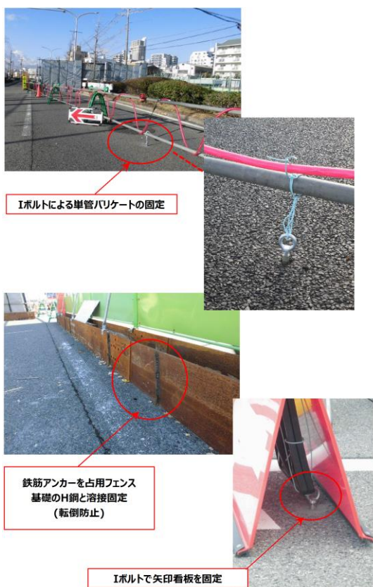
写真5 占用資材固定状況
