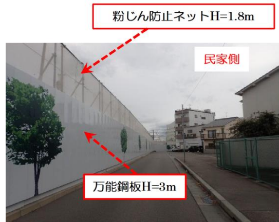
写真3 粉じん防止ネットを追加設置した仮囲い
