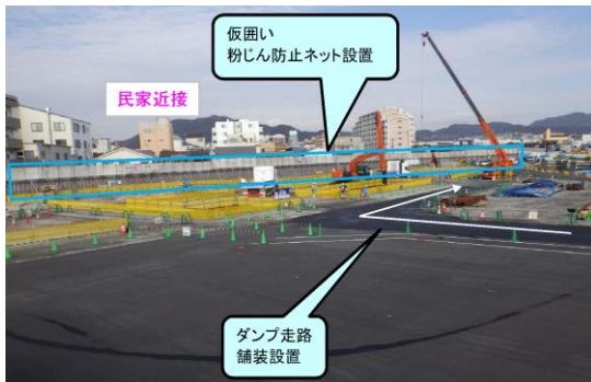
写真2 掘削作業時
