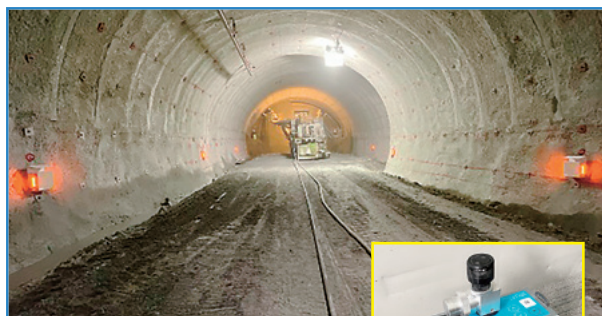
上：粉じん濃度測定6箇所 (切羽～10m、30m、50mの両側) 右：デジタル粉じん計 (PM4サイクロン付)
