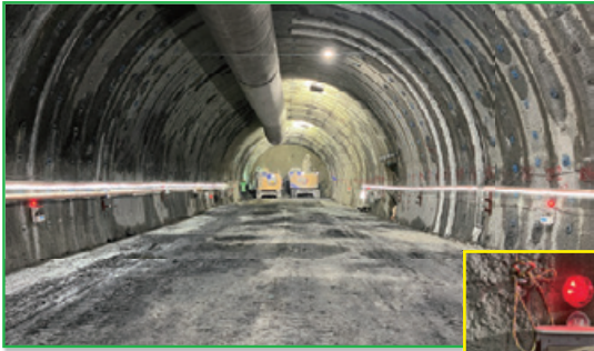
切羽から10・30・50m両側6カ所測定
